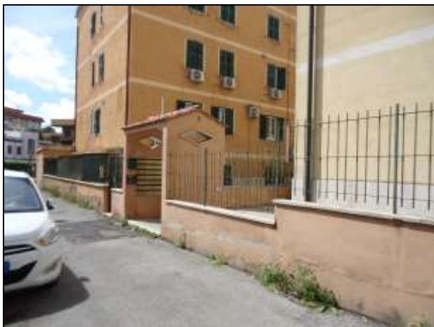
Foto 2 – Veduta esterna dell'edificio – 24.04.2024
