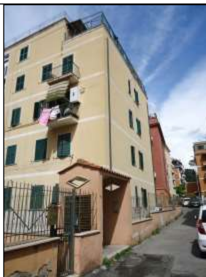
Foto 5 – Veduta esterna dell'edificio – 24.04.2024
