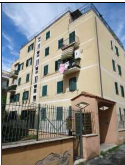
Foto 4 – Veduta esterna dell'edificio – 24.04.2024
