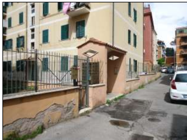
Foto 3 – Veduta esterna dell'edificio – 24.04.2024
