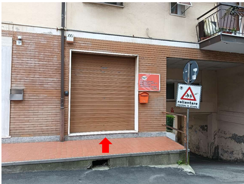
Vista da Via G. Macciò
