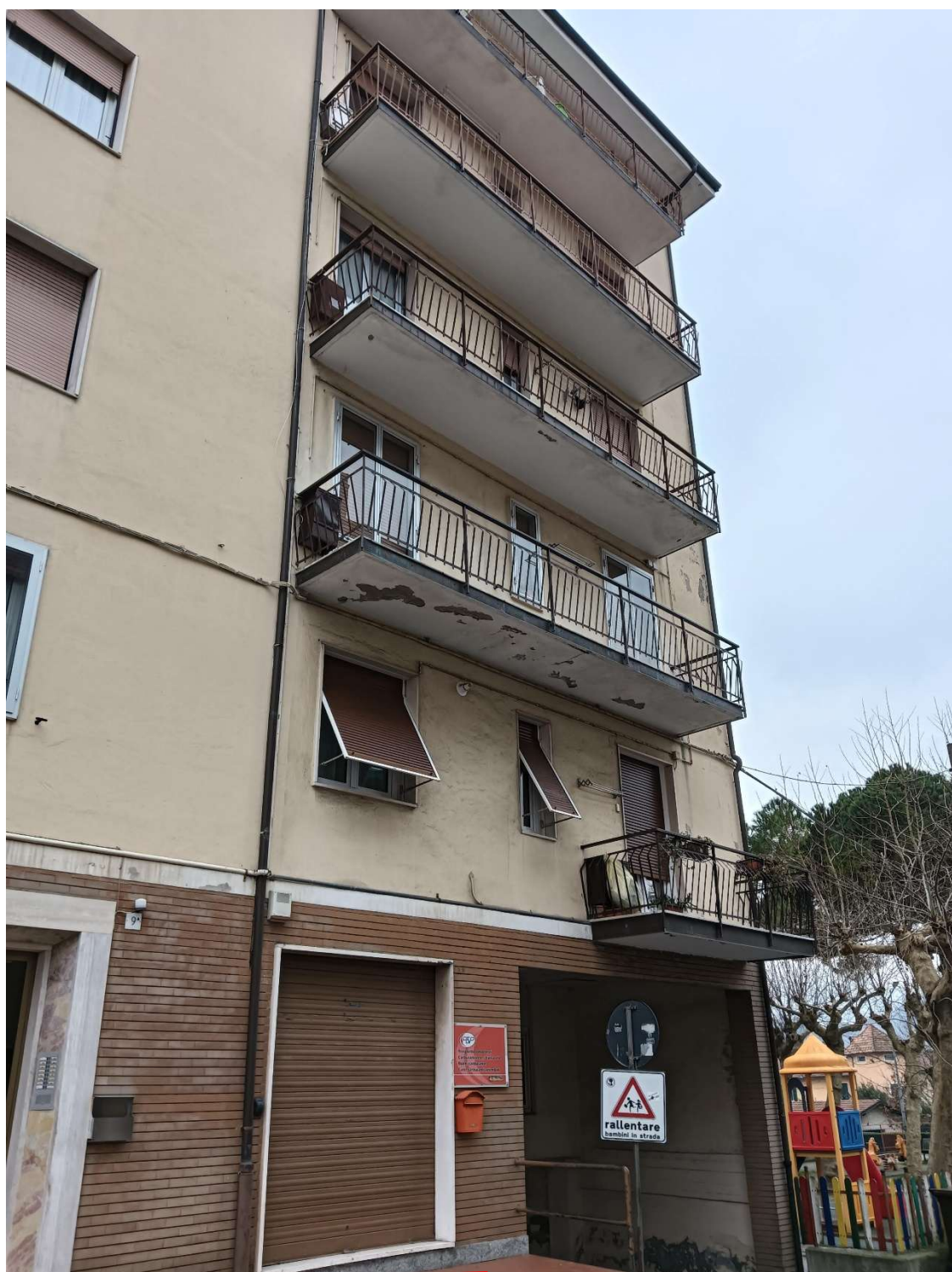
Vista da Via G. Macciò
