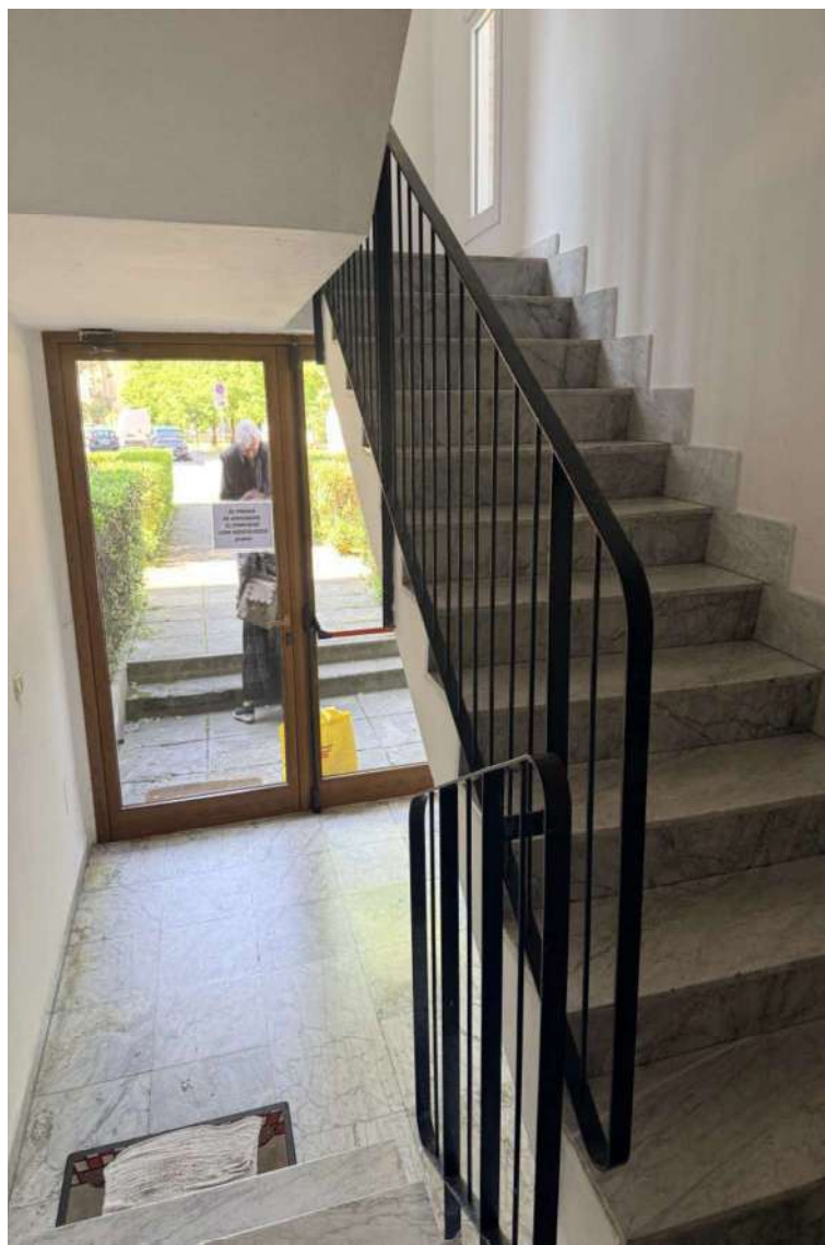
Figura 2: Vista interna, androne e scale condominiali
