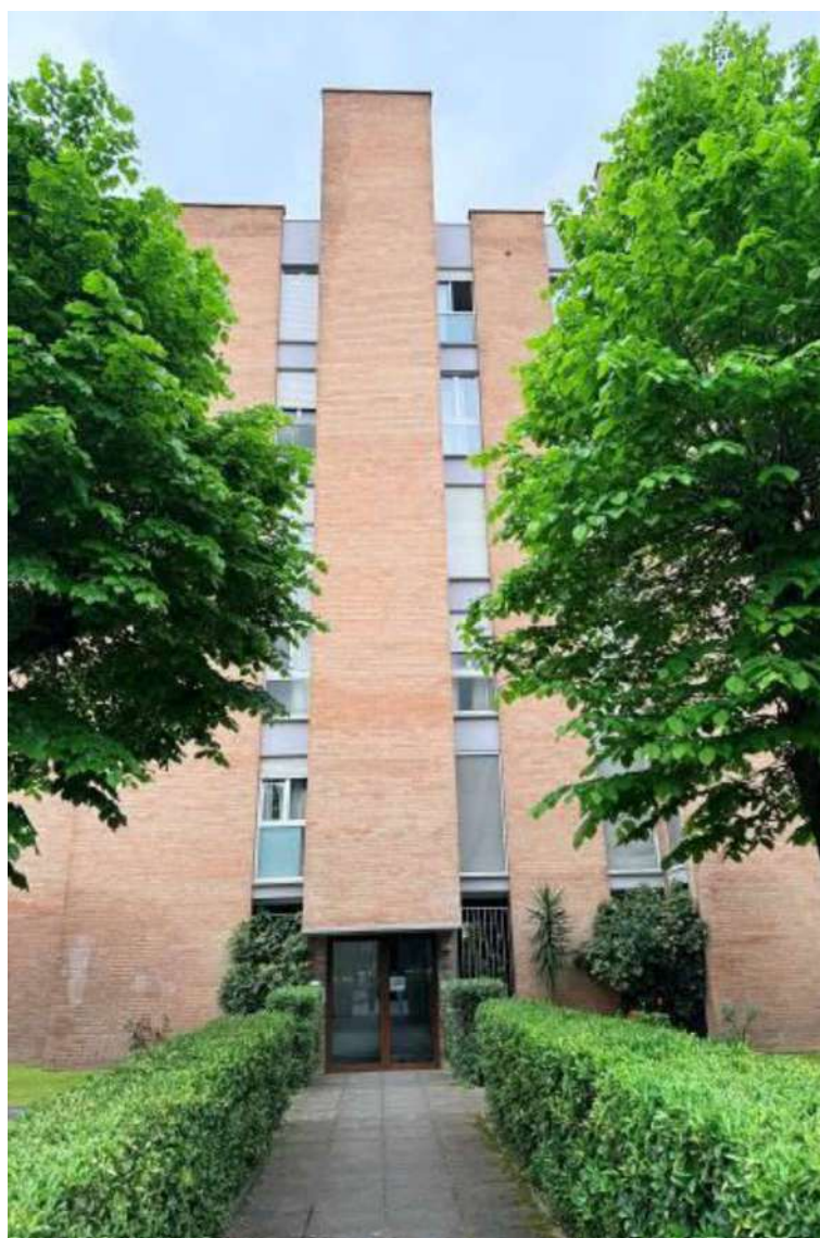
Figura 1: Vista esterna, fabbricato condominiale
