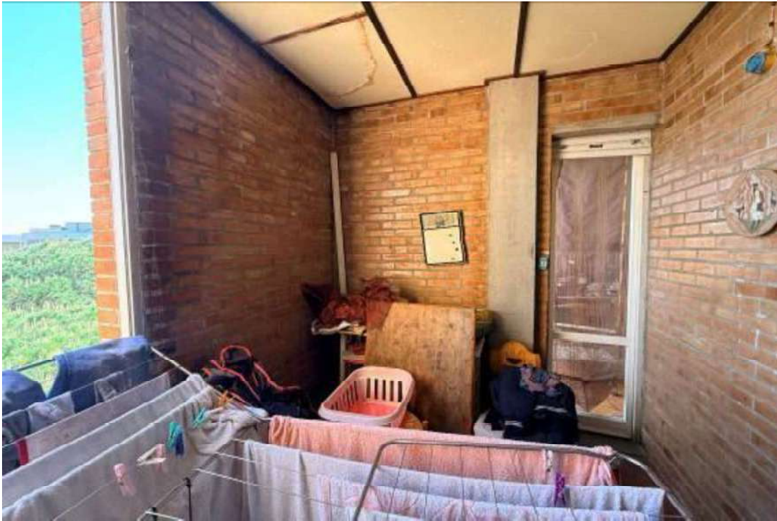
Figura 16: Vista interna, veranda BENE 1
