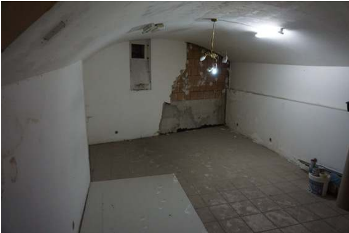
Fig.10 – Vano deposito seminterrato
