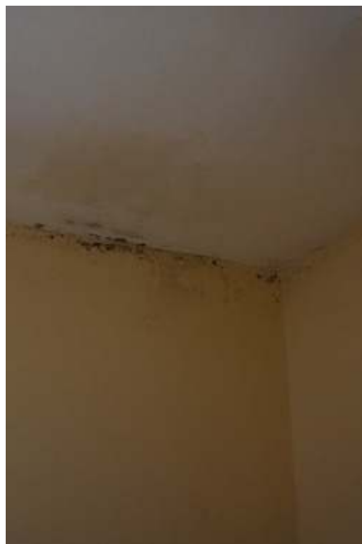
Fig.14-15 – Vista dei fenomeni di condensa
