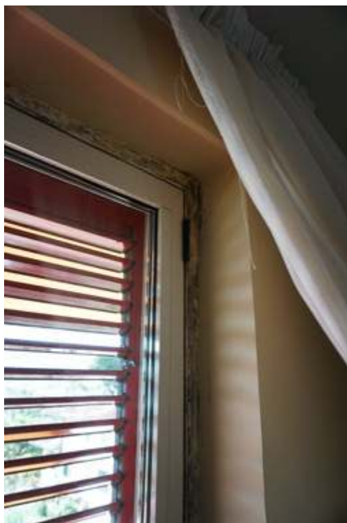
Fig.14-15 – Vista dei fenomeni di condensa
