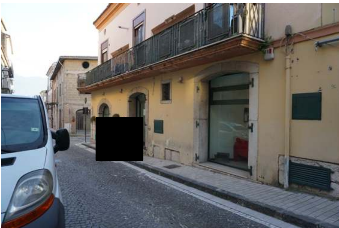
Fig.2 – Vista accessi da Corso Caudino
