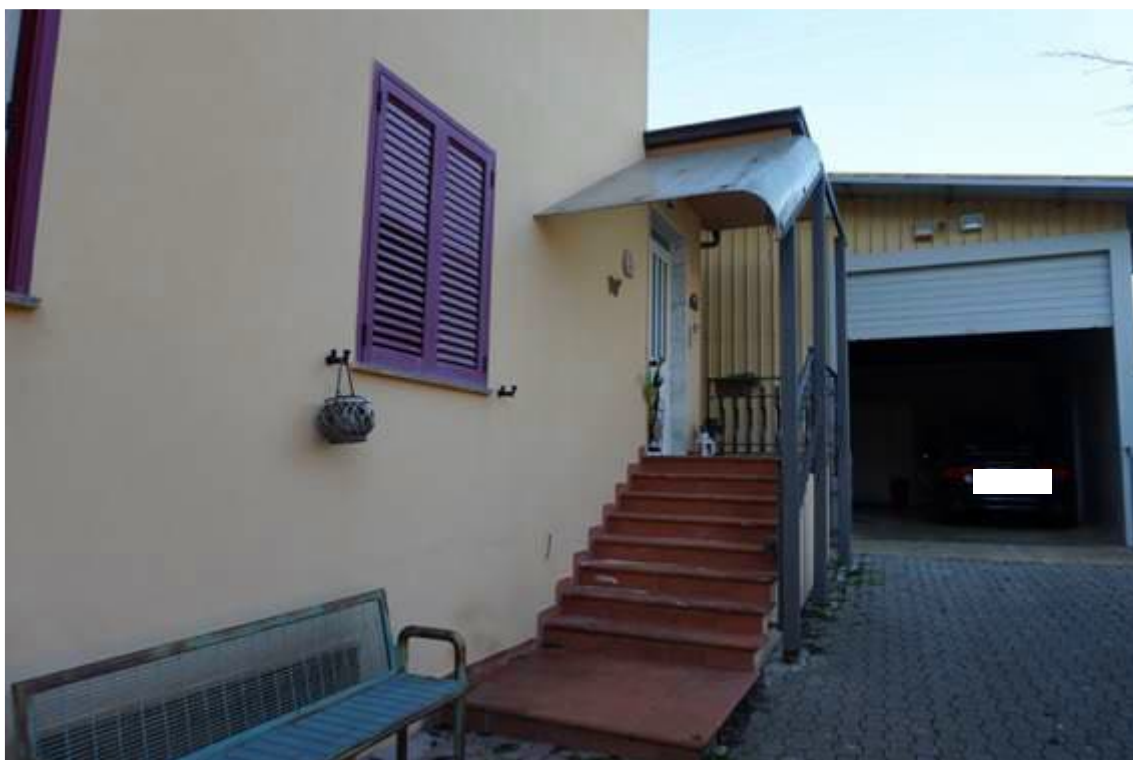
Fig.4 – Vista su vano scala/profferlo
