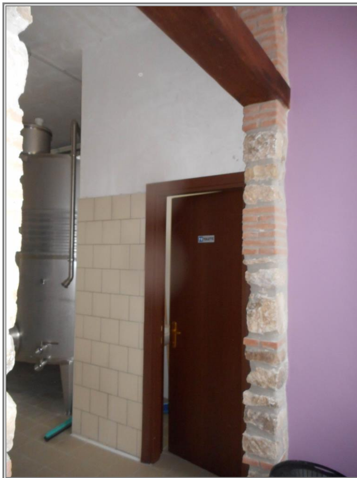
FOTO 15-16 – Particella 1035 sub 2 (Depositi): il wc e il piccolo locale ripostiglio ricavati nel grande ambiente cantina
