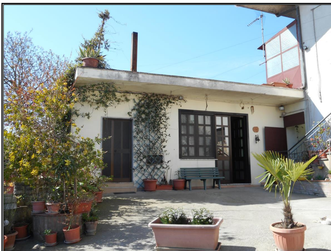
FOTO 2 – Particella 1035 sub 3 (Abitazione) : il corpo pertinenziale con gli accessi al wc e al tinello.
