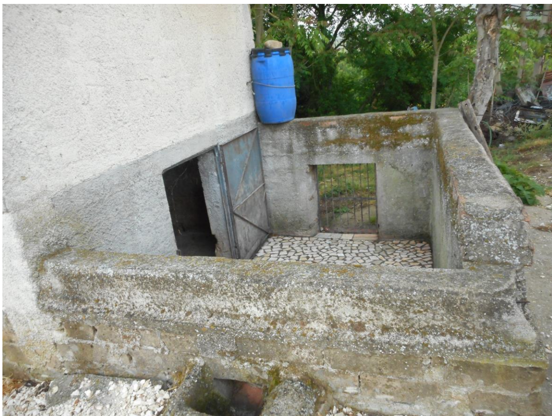
FOTO 3 – Particella 1036 (Ricovero animali): l'accesso al livello seminterrato sul prospetto laterale dx
