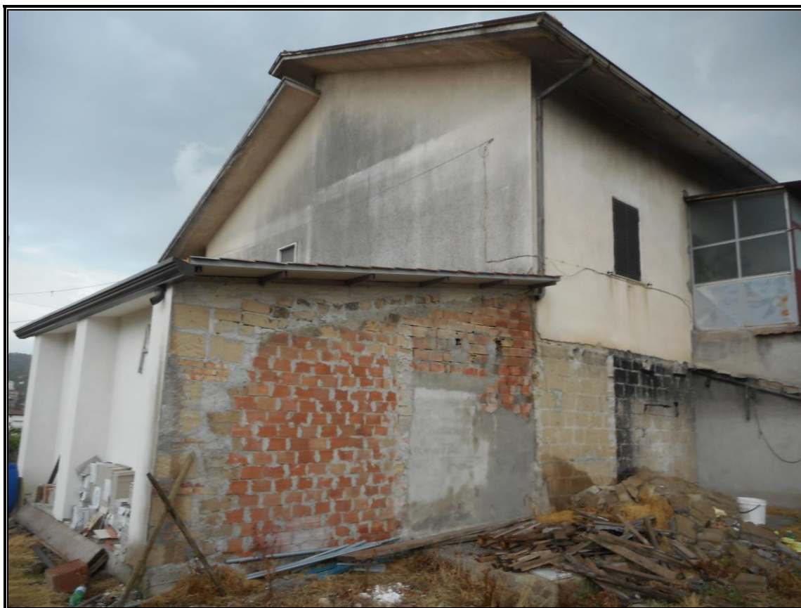
FOTO 5 – Particella 1035 sub 3 e sub 2 (Abitazione - Pertinenze): i prospetti posteriore e laterale sx
