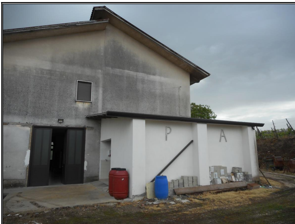
FOTO 6 – Particella 1035 sub 3 e sub 2 (Abitazione - Depositi): il locale deposito attrezzi e l'ingresso posteriore alla cantina ad uso conservazione del vino.
