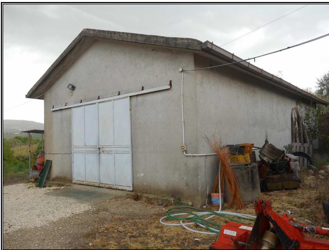
FOTO 1 – Particella 957 sub 2 (Deposito) : i prospetti principale e laterale dx
