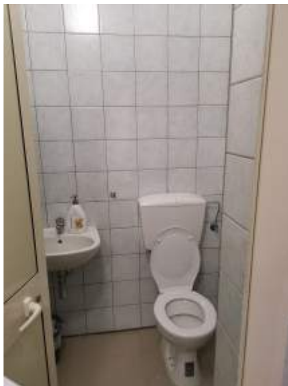
Figura 13: Wc Piano Interrato
