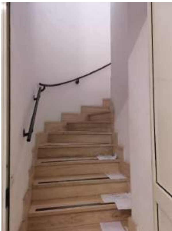
Figura 1: Scala Interna collegamento piano terra-piano primo
