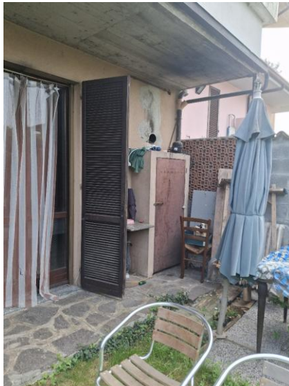
VISTA FRONTE GIARDINO
