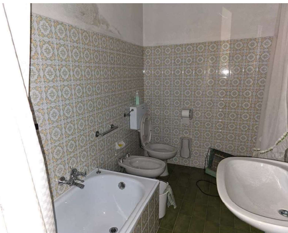
Foto n. 10 : C.F. Fg. 38 mapp. 72 sub 2 - Piano primo, bagno
