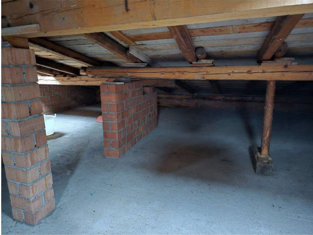
Foto n. 19 : C.F. Fg. 38 mapp. 72 - Soffitta comune
