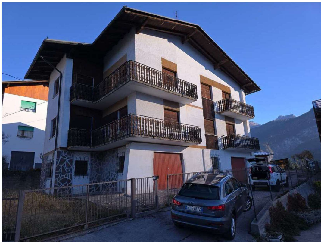
Foto n. 1 : C.F. Fg. 38 mapp. 72 - Fabbricato, vista da sud
