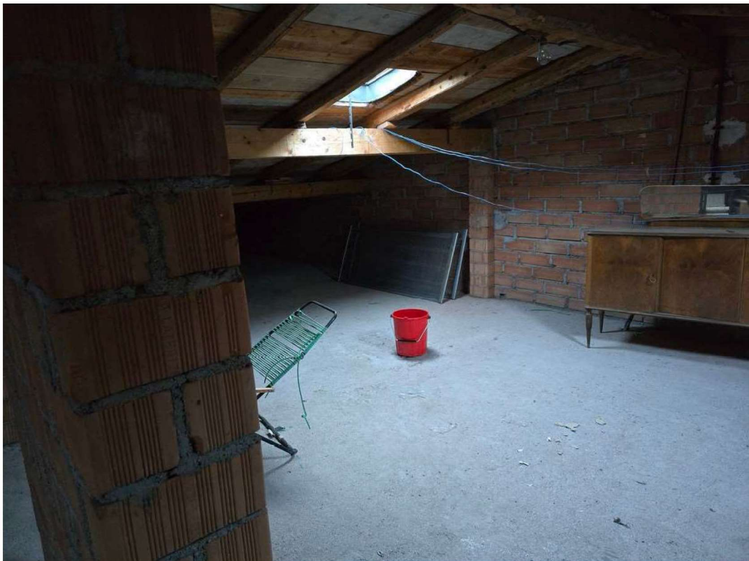
Foto n. 20 : C.F. Fg. 38 mapp. 72 - Soffitta comune
