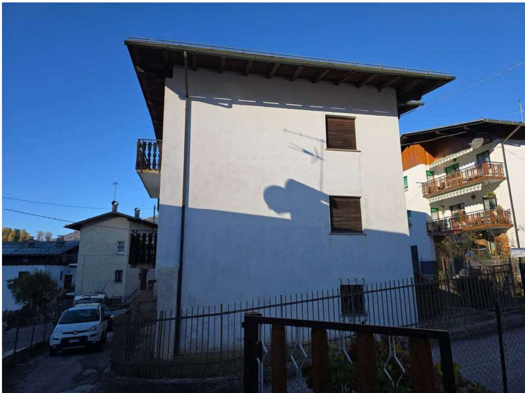
Foto n. 4 : C.F. Fg. 38 mapp. 72 - Fabbricato, vista da est
