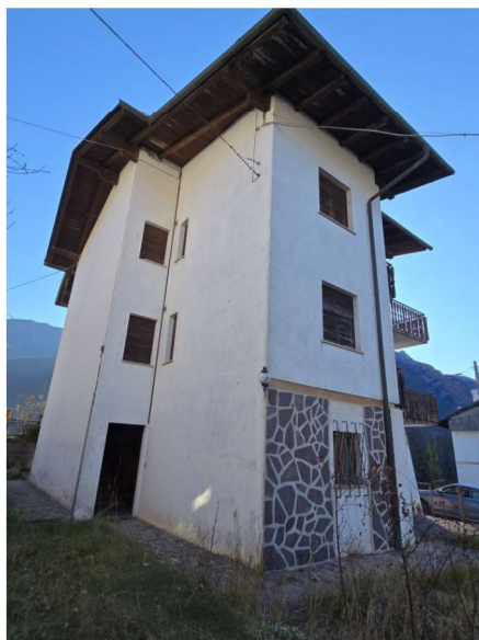
Fabbricato mappale 72, vista da ovest
