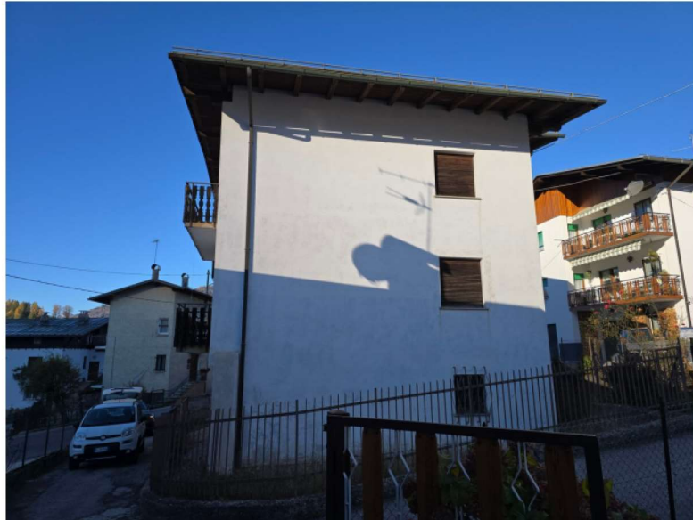
Fabbricato mappale 72, vista da est
