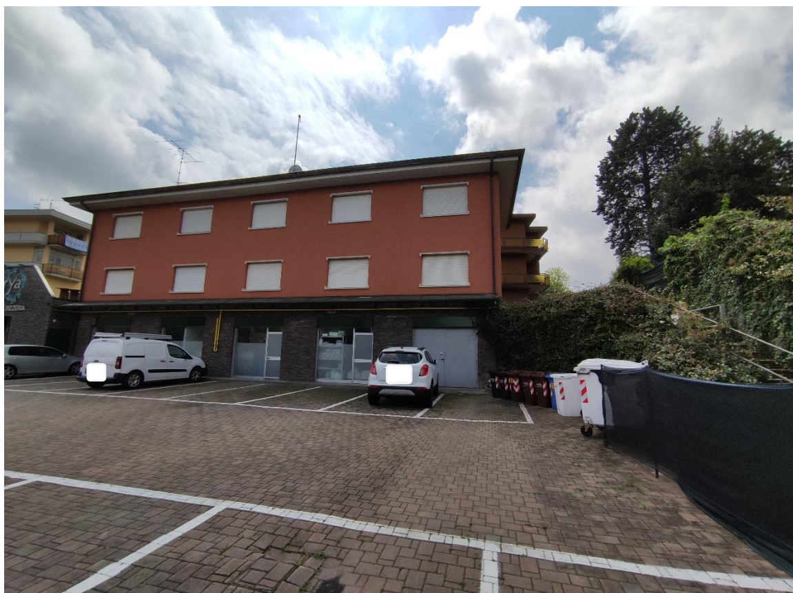
Vista fronte nord e parcheggio
