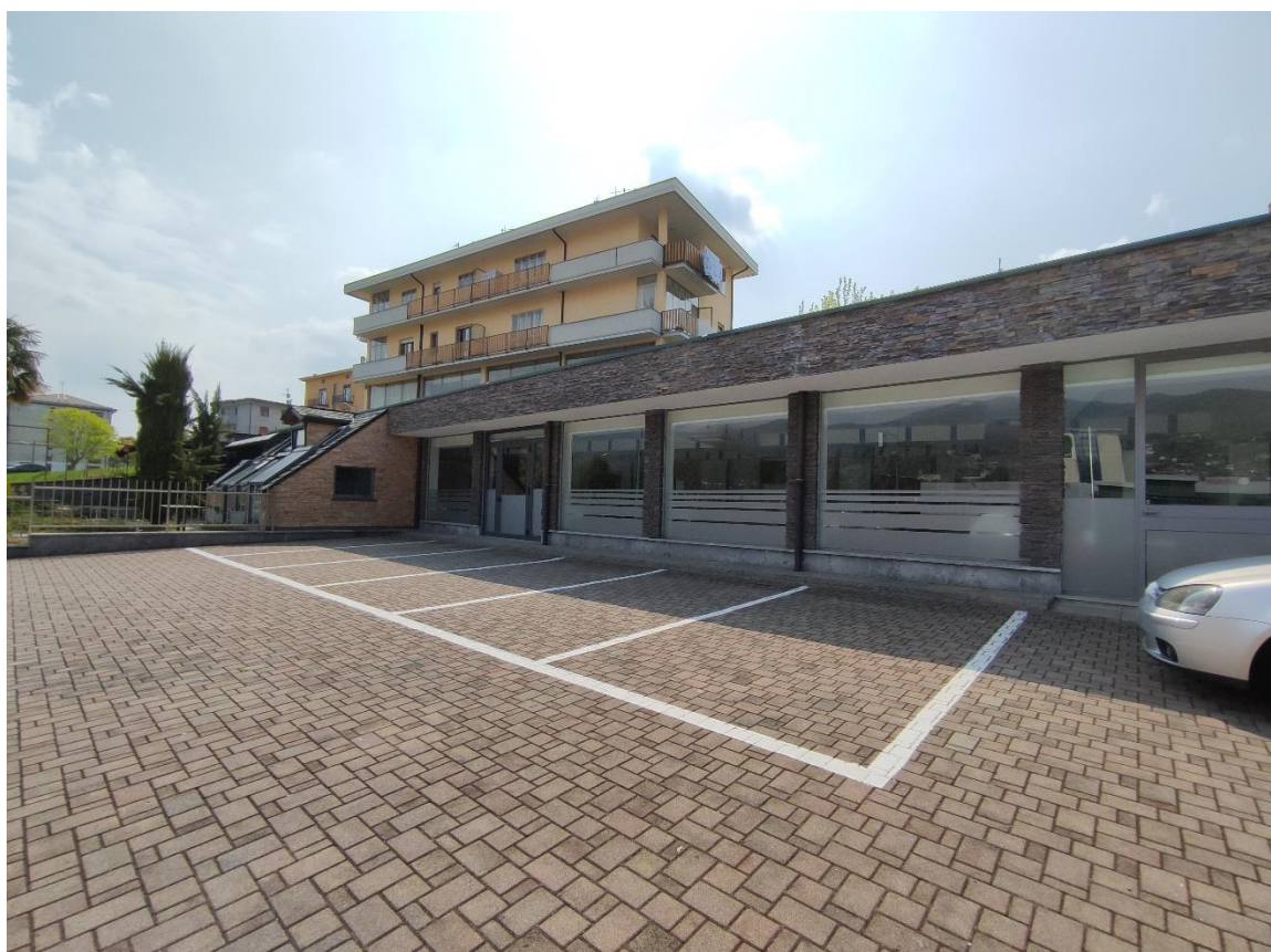
Vista fronte nord e parcheggio
