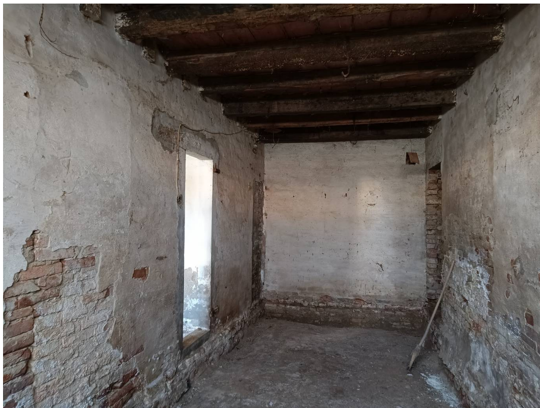
Foto 23 scorcio interno PT.
