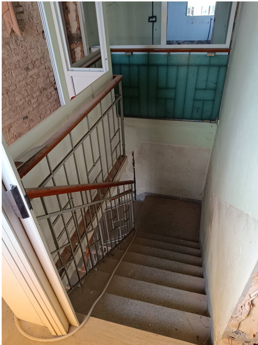
Foto 26 vista della scala interna.
