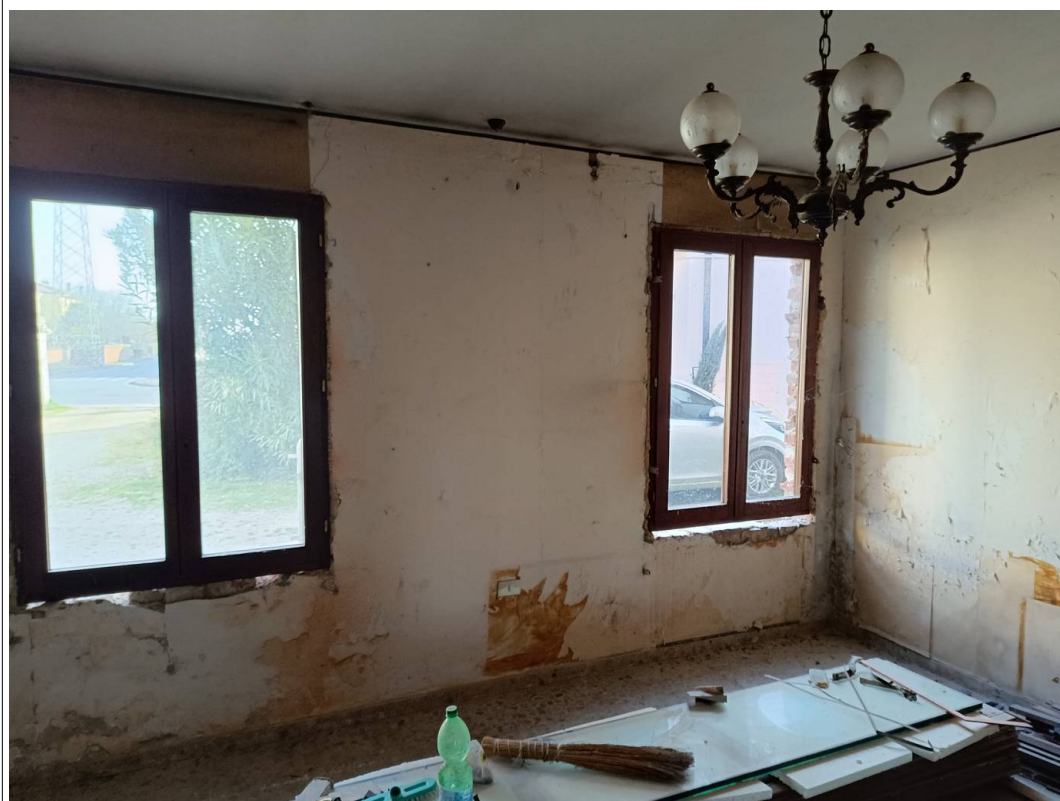
Foto 14 scorcio interno PT.
