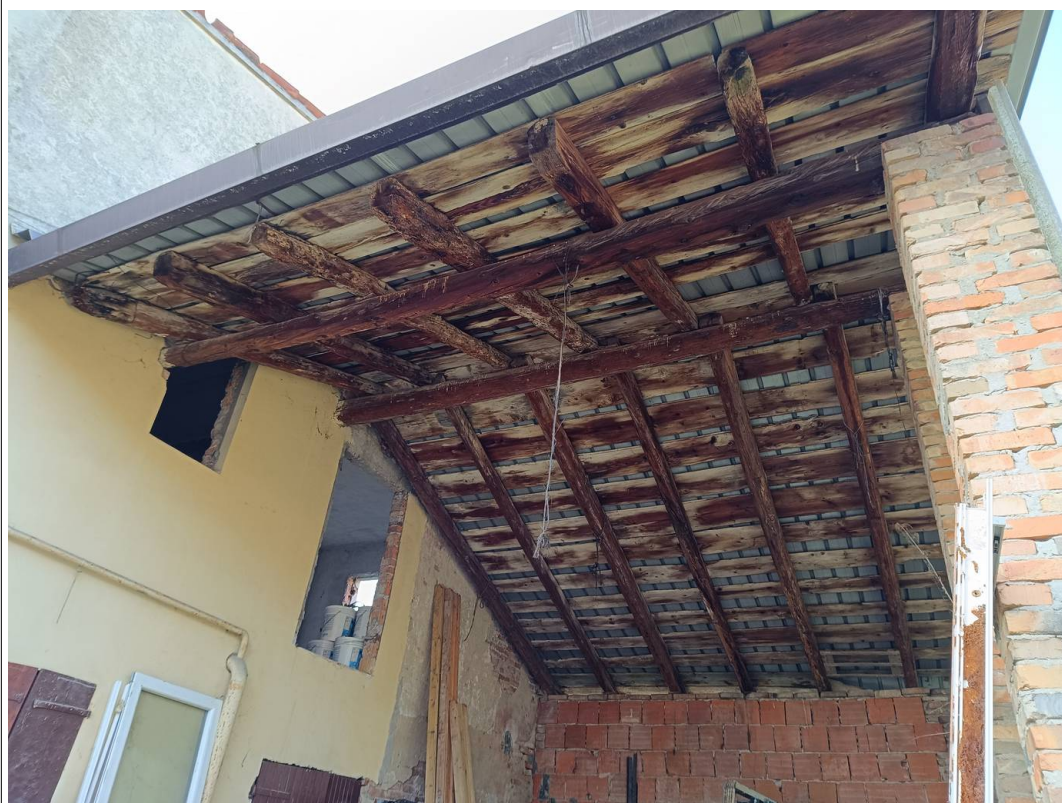
Foto 12 vista della tettoia.
