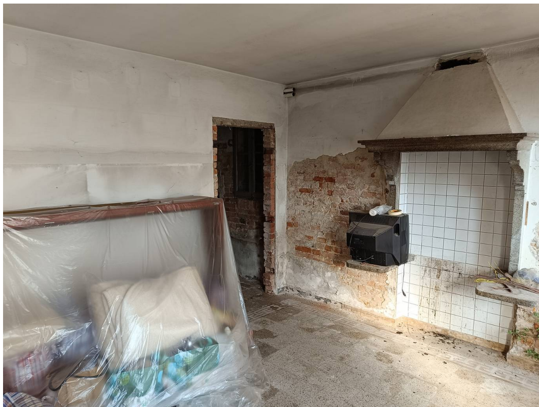
Foto 17 scorcio interno PT.
