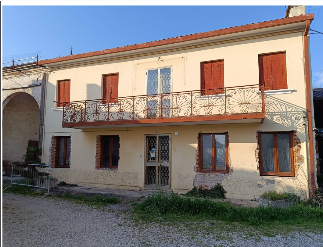
Foto 7 vista dell'edificio oggetto di stima.
