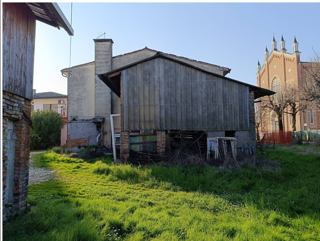
Foto 8 vista dell'edificio oggetto di stima.
