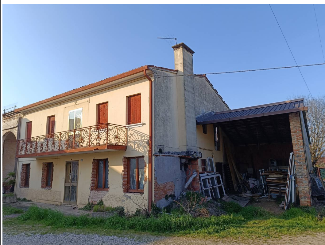
Foto 4 vista dell'edificio oggetto di stima.
