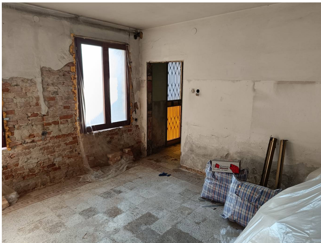
Foto 18 scorcio interno PT.
