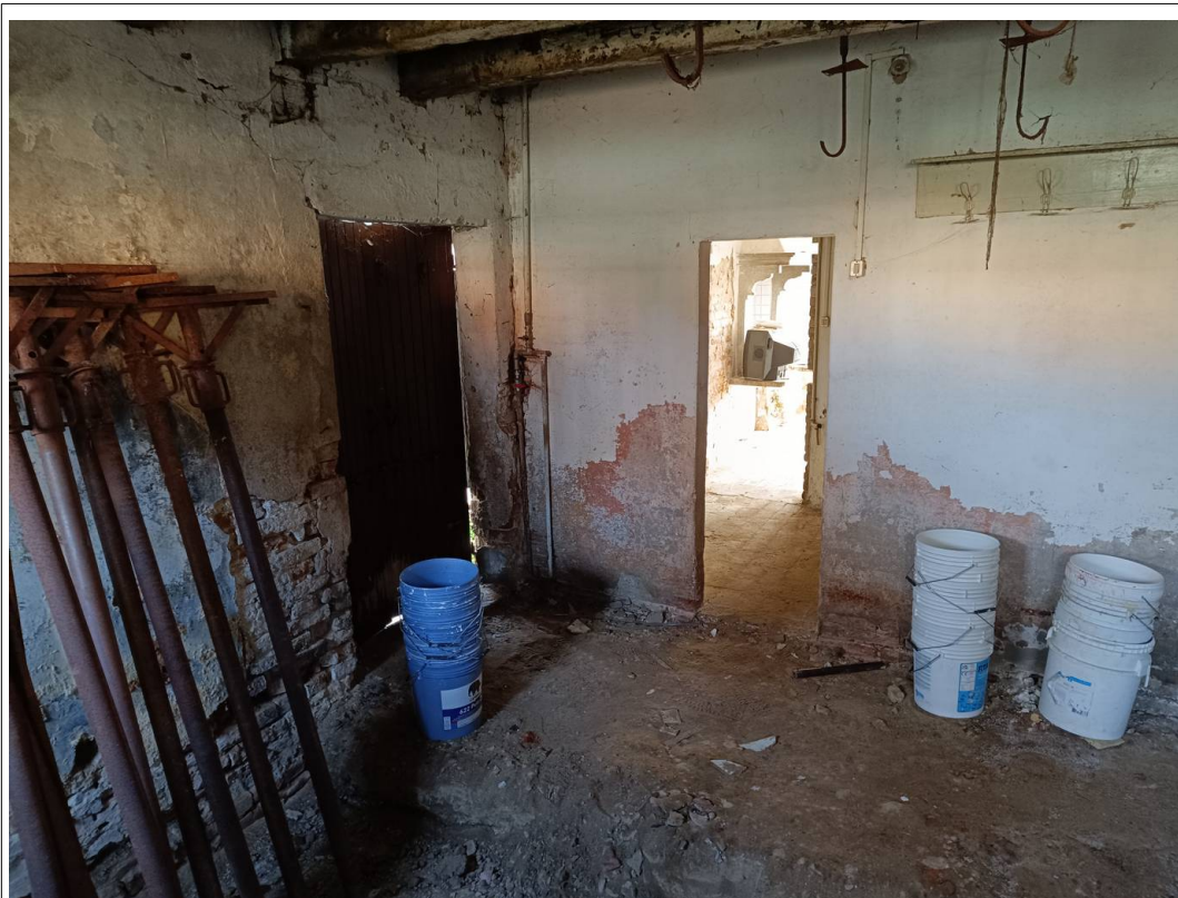
Foto 21 scorcio interno PT.
