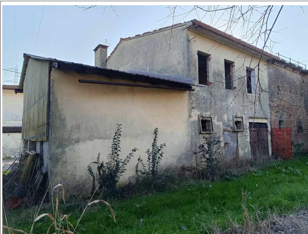
Foto 9 vista dell'edificio oggetto di stima sul retro.
