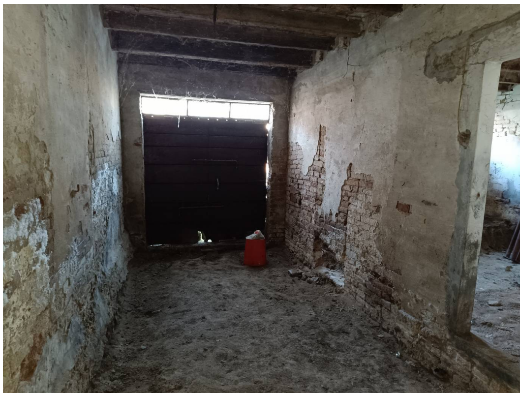
Foto 24 scorcio interno PT.
