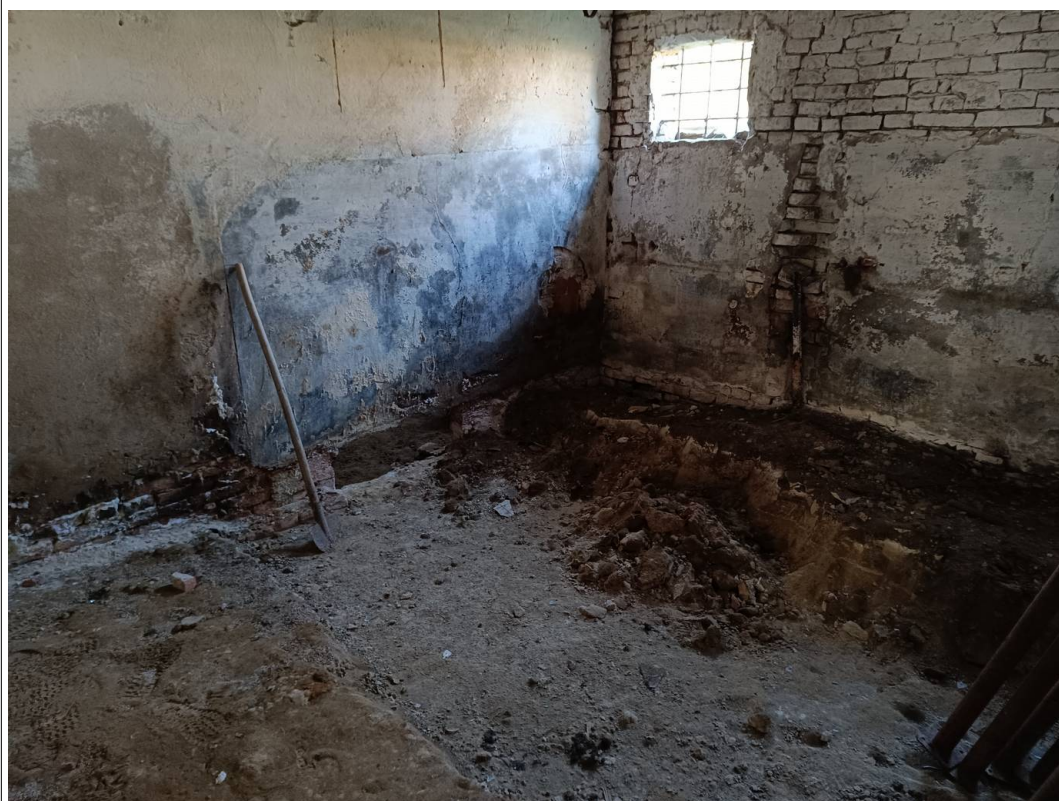
Foto 22 scorcio interno PT.
