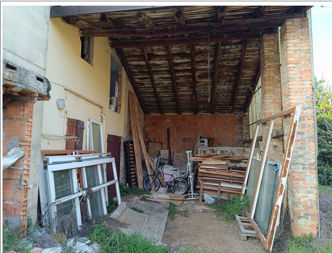
Foto 11 vista della tettoia.
