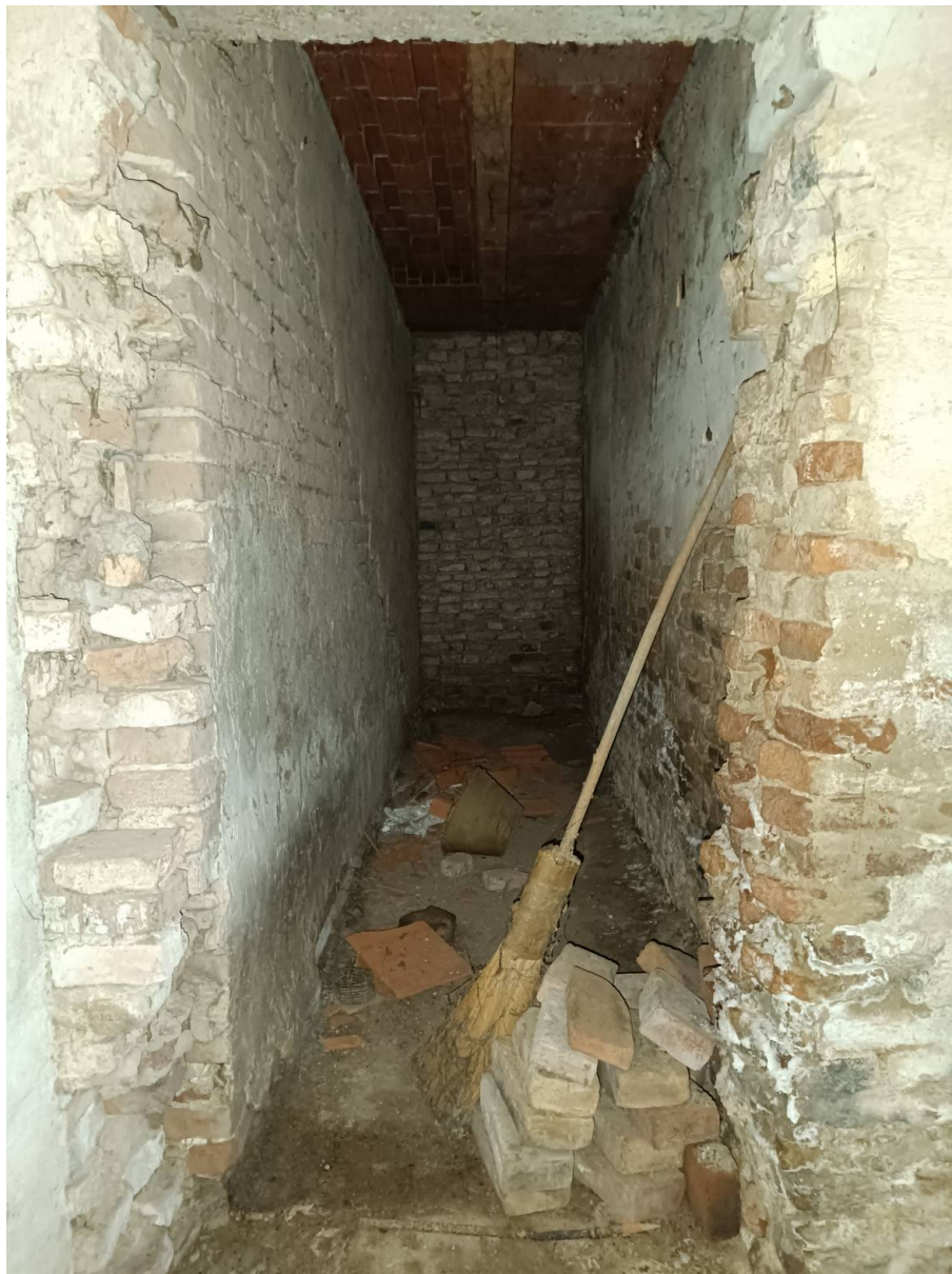
Foto 25 scorcio interno PT.
