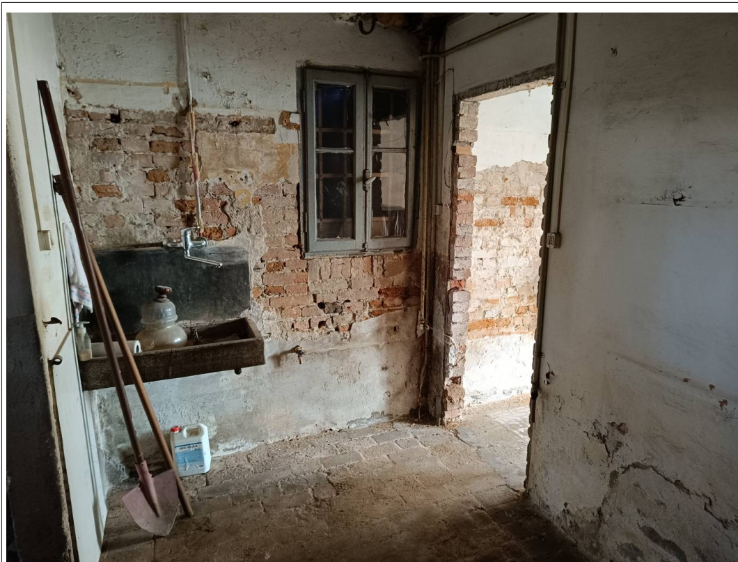
Foto 19 scorcio interno PT.
