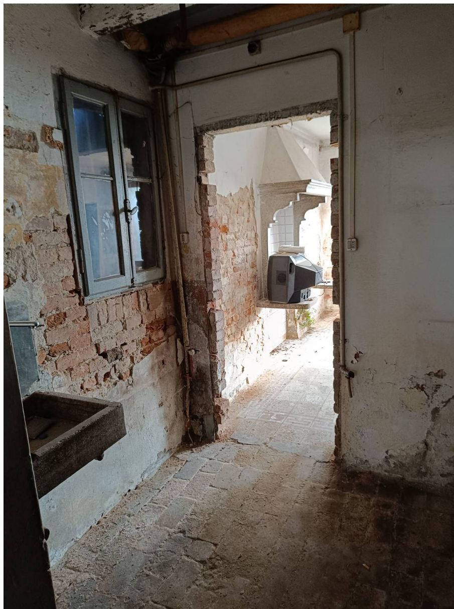
Foto 20 scorcio interno PT.
