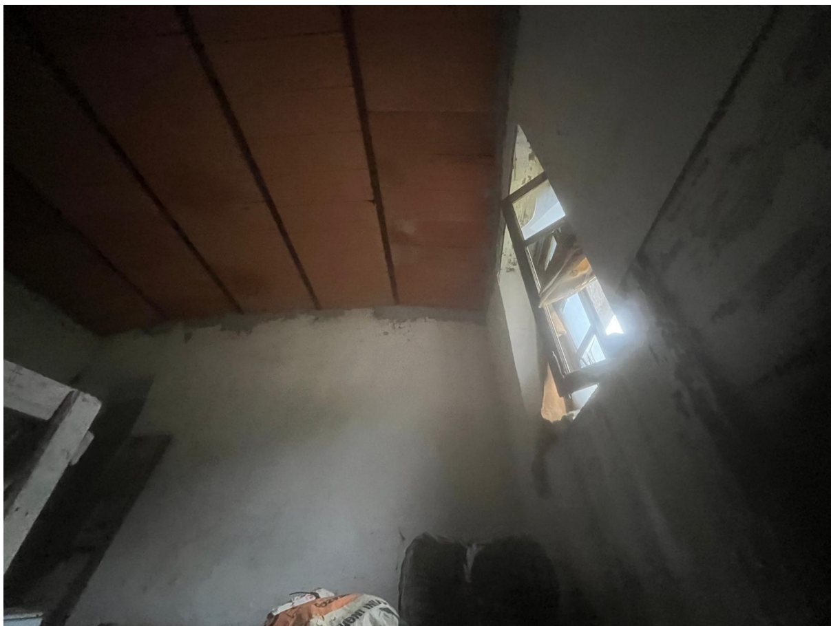
LOCALE DEPOSITO FABBRICATO B
