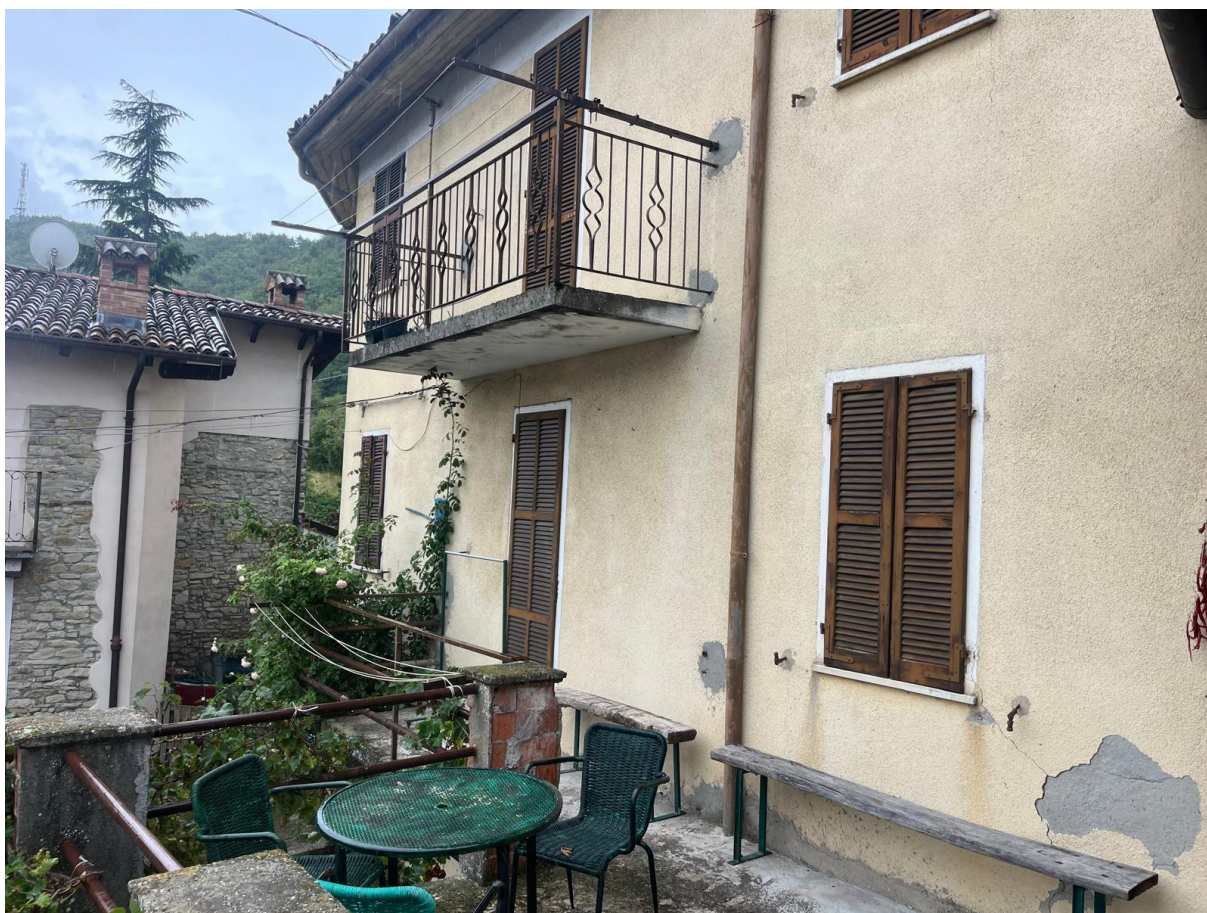
TERRAZZO FABBRICATO A
