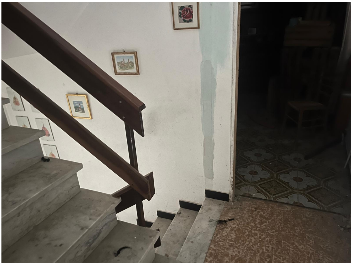
VANO SCALA FABBRICATO A
