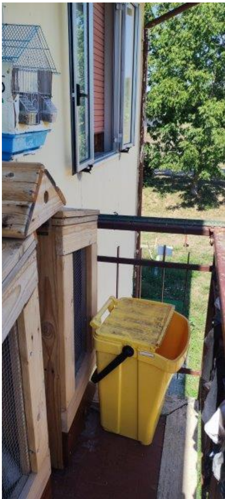
Figura 12 Terrazza fabbricato abitativo n°4
