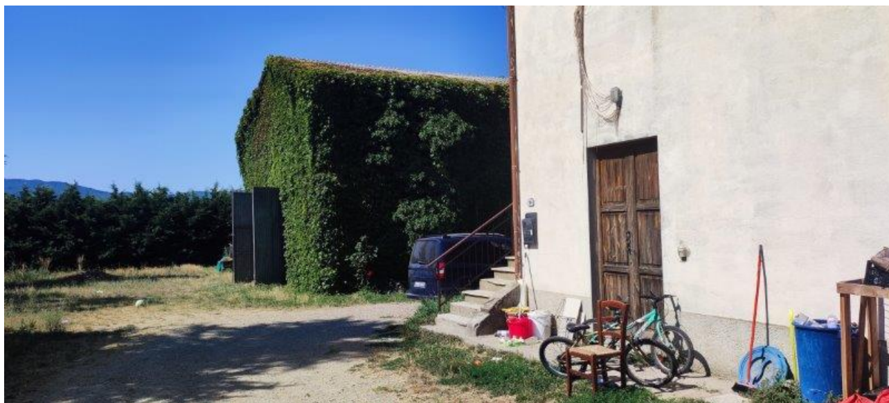
Figura 7 Particolare Fabbricato abitativo e Deposito
