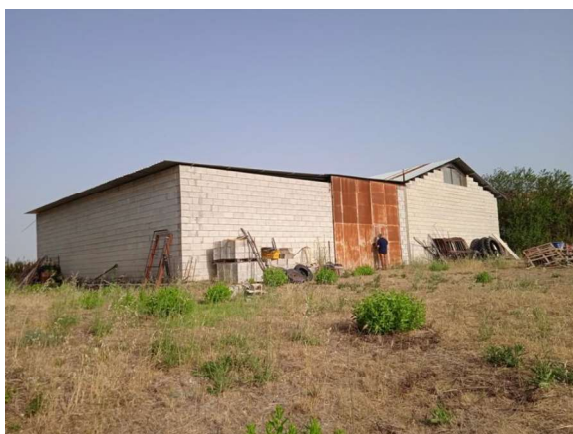
Vista esterna fabbricato
