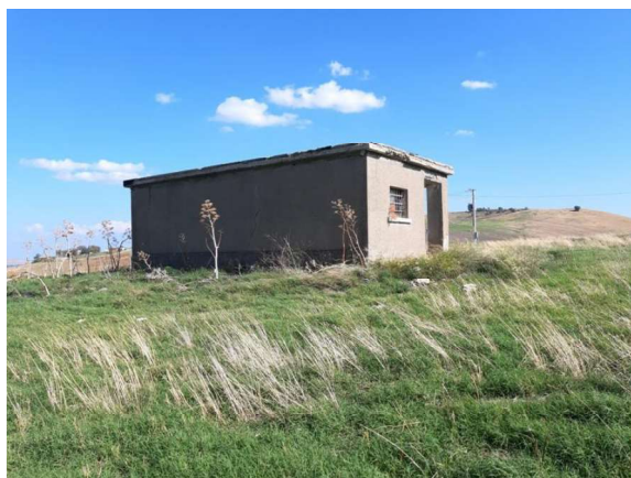
Vista esterna fabbricato
