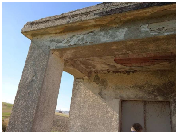
Part. 811 sub 2 - Vista interna
