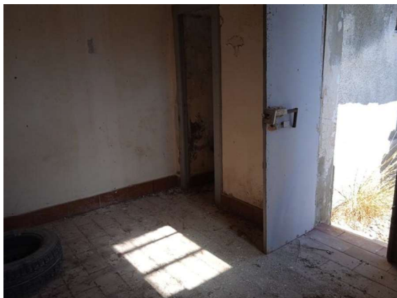
Part. 811 sub 2 - Vista interna
