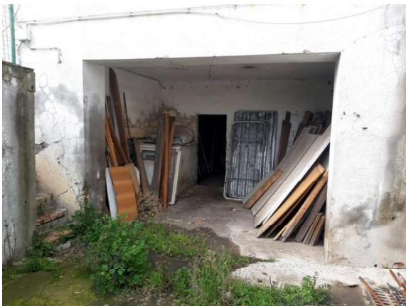
Vista portico e deposito
