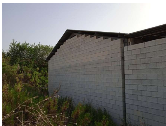
Vista esterna fabbricato
