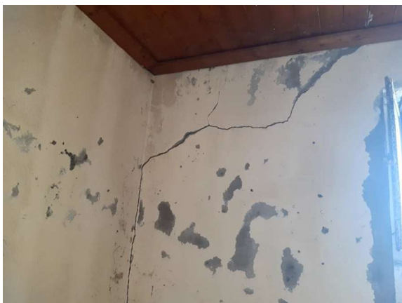
Part. 811 sub 2 - Vista interna
