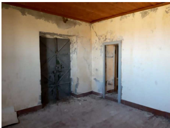
Part. 811 sub 2 - Vista interna
