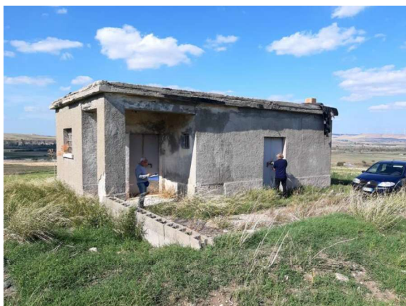
Vista esterna fabbricato
