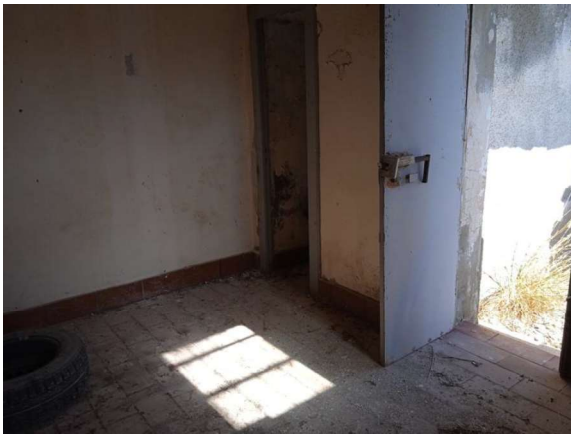
Part. 811 sub 2 - Vista interna
