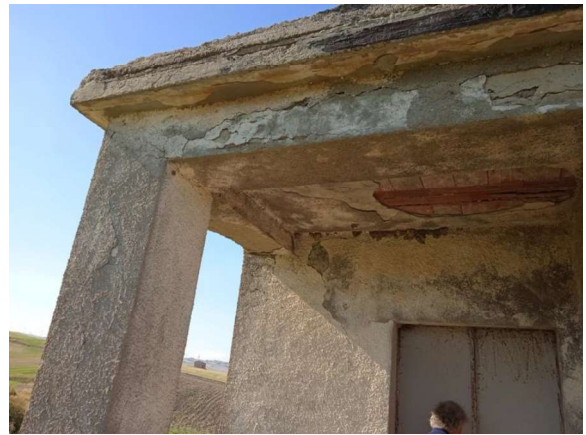
Part. 811 sub 2 - Vista interna
