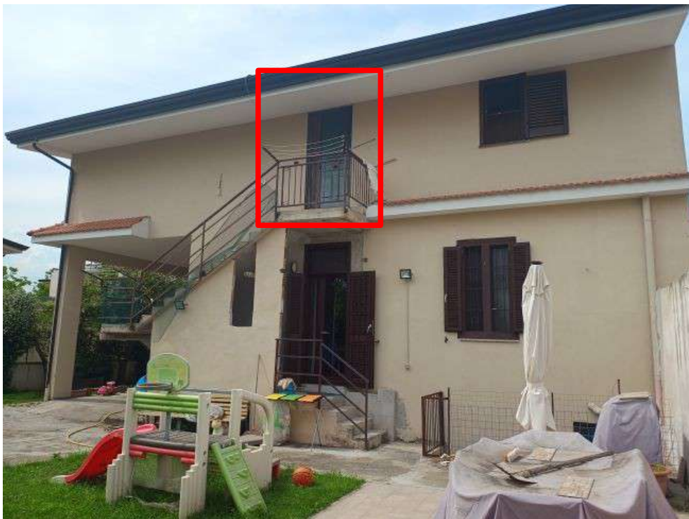
FOTO N. 12 – Vista della facciata retrostante del fabbricato con porta di ingresso dell'appartamento
