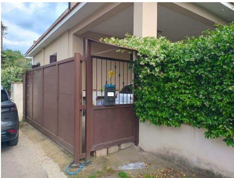
FOTO N. 2 – Cancelli di ingresso pedonale e carrabile
