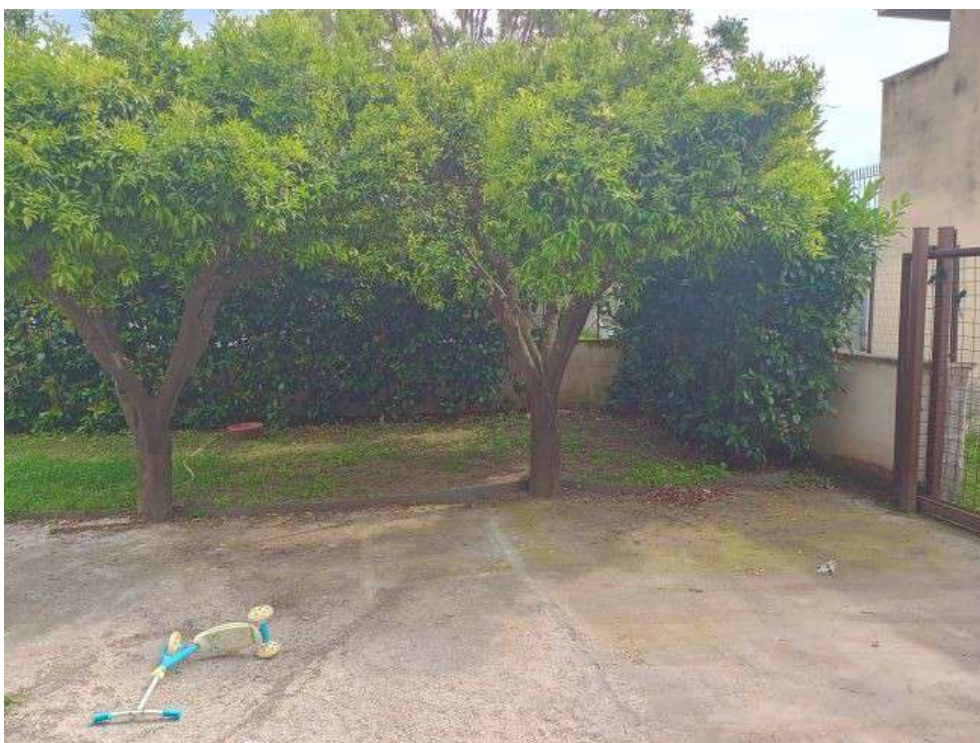
FOTO N. 10 – Vista del muro confine retrostante il fabbricato
