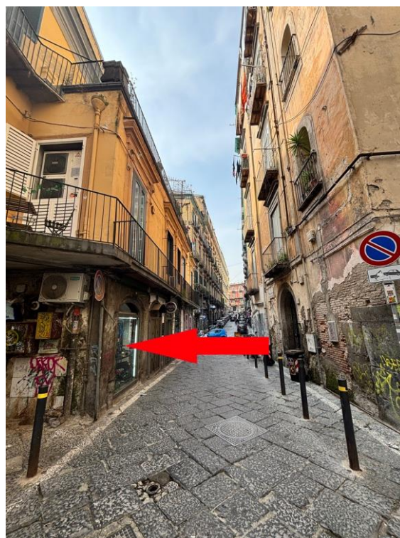
Vista portone di ingresso allo stabile
