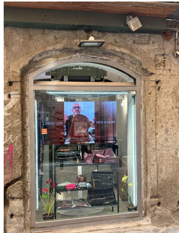
Vista esterna immobile pignorato
