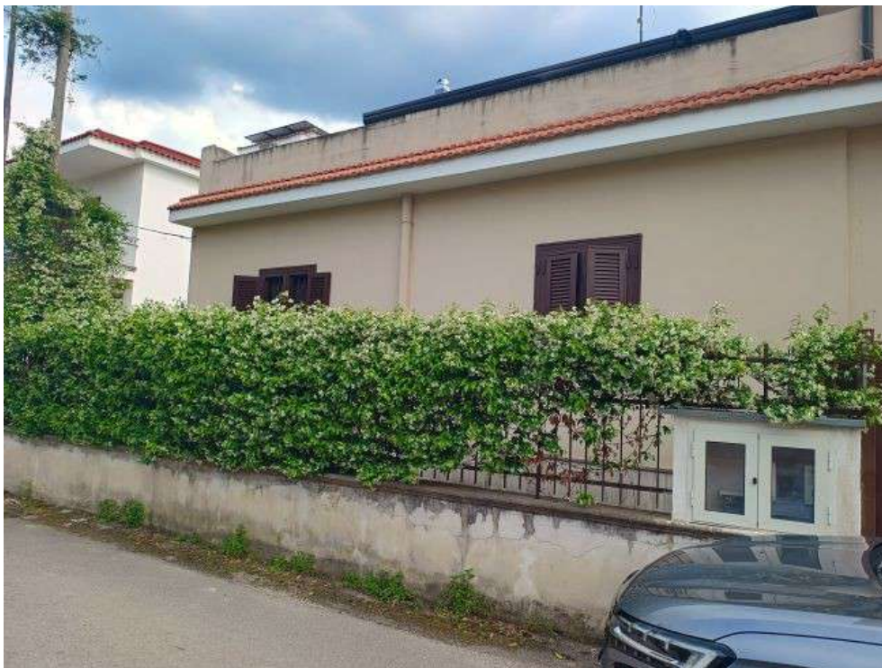
FOTO N. 3 – Dettaglio del fabbricato e del muro di confine con Via Campo
