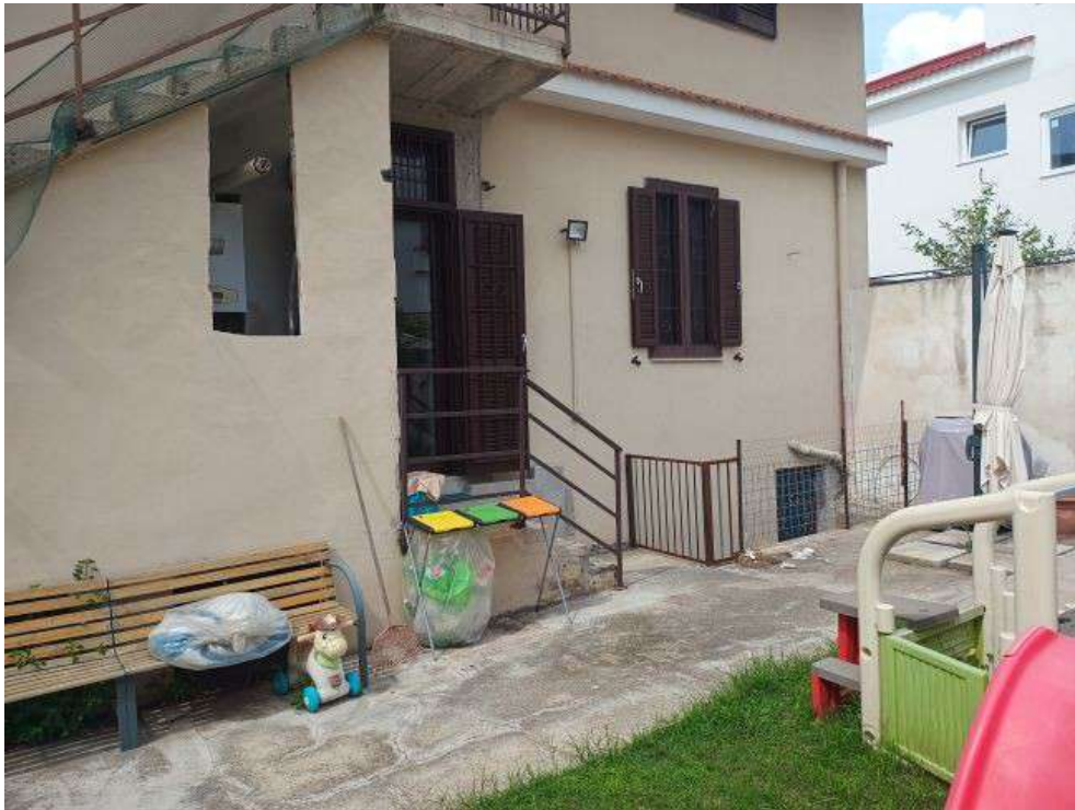
FOTO N. 15 – Facciata retrostante del fabbricato con scala per l'accesso al piano cantinato
