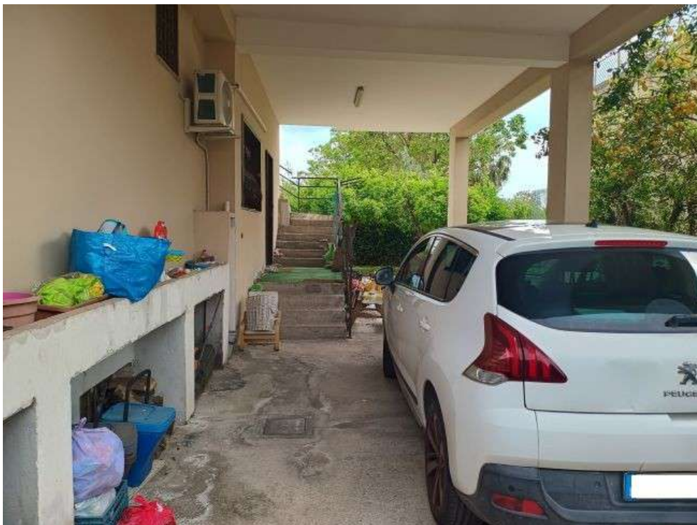
FOTO N. 6 – Vista del porticato sub. 6 posto a copertura della scala esterna
