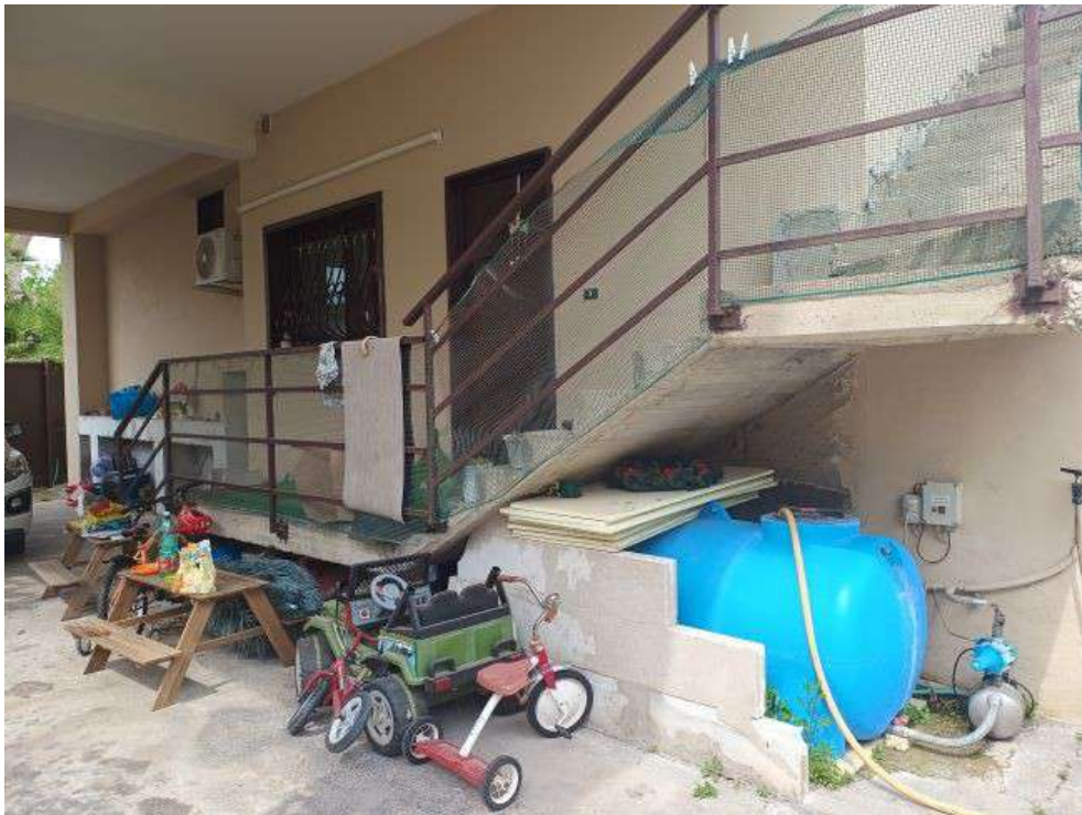
FOTO N. 14 – Altra vista della scala esterna comune sub. 9
