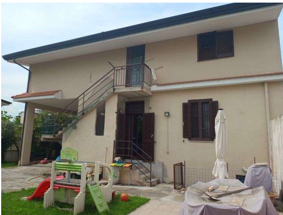
FOTO N. 12 – Vista della facciata retrostante del fabbricato
