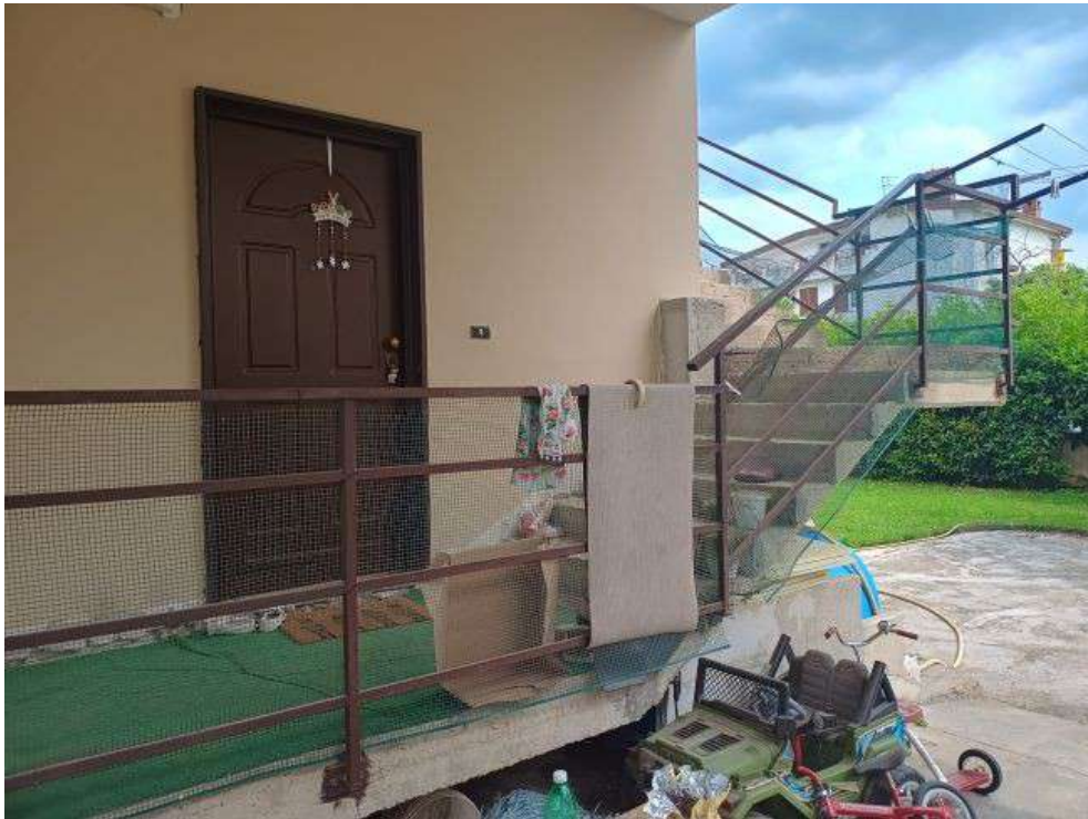
FOTO N. 13 – Porta di ingresso dell'appartamento sub. 10 posto al piano terra rialzato
