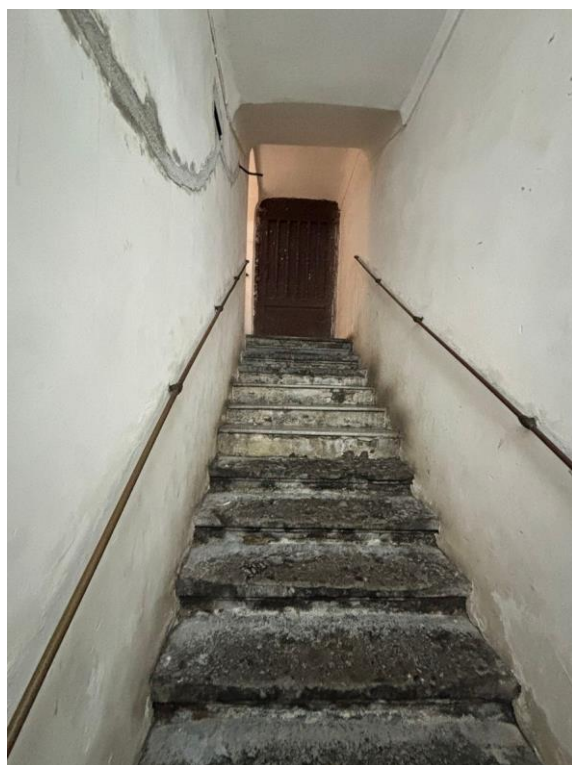
Rampa scale di ingresso immobile in cui sono allocati i beni
