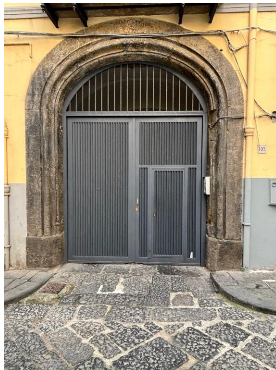
Vista portone di ingresso allo stabile
