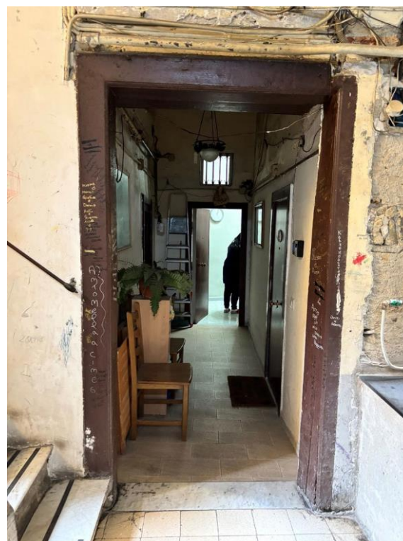
Pianerottolo di smonto secondo piano Per accesso al bene
