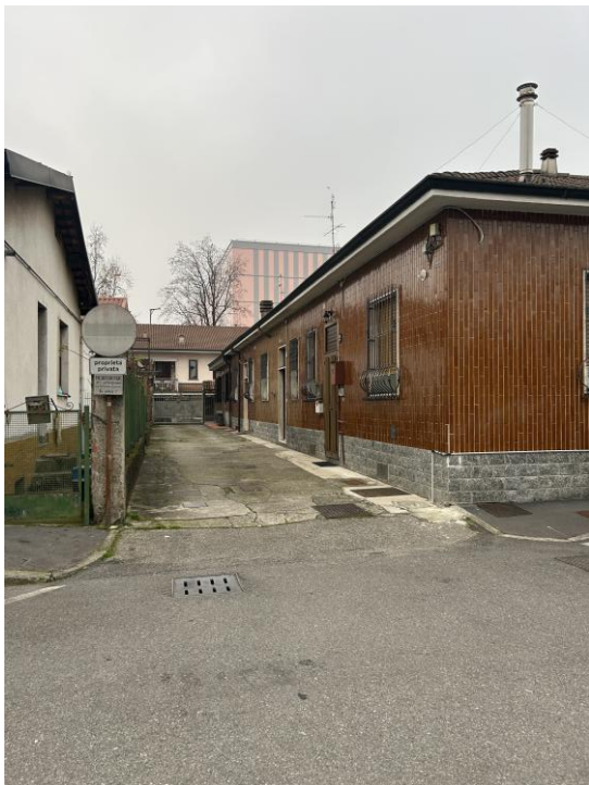
Foto 1 – spazi comuni esterni di accesso alle unità immobiliari
