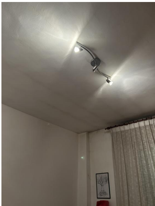
Foto 25: soffitto della camera
