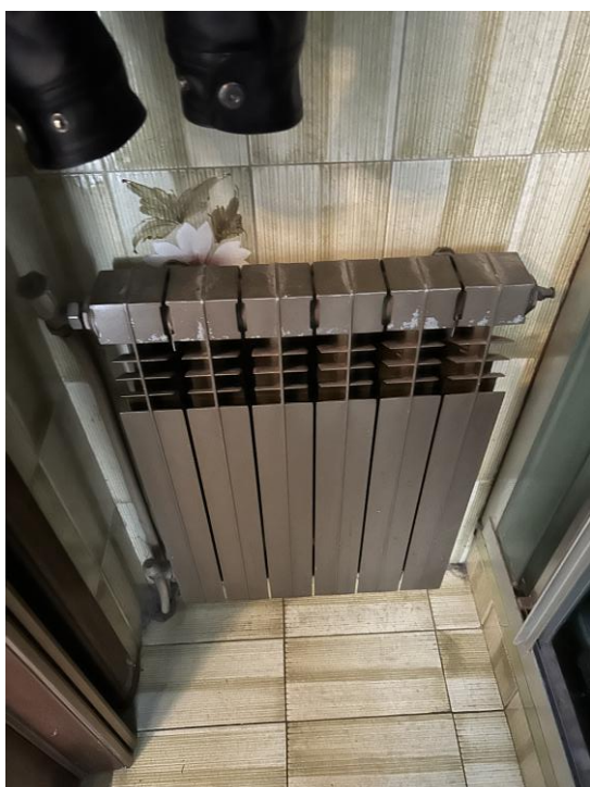
Foto 15 – bagno dettaglio calorifero
