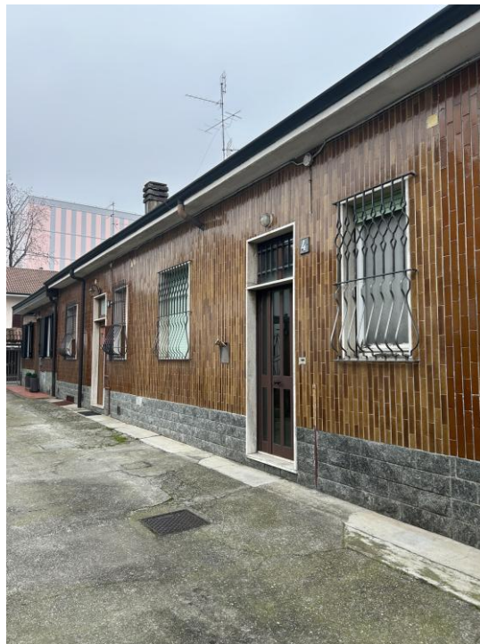
Foto 2 – spazi comuni esterni di accesso alle unità immobiliari
