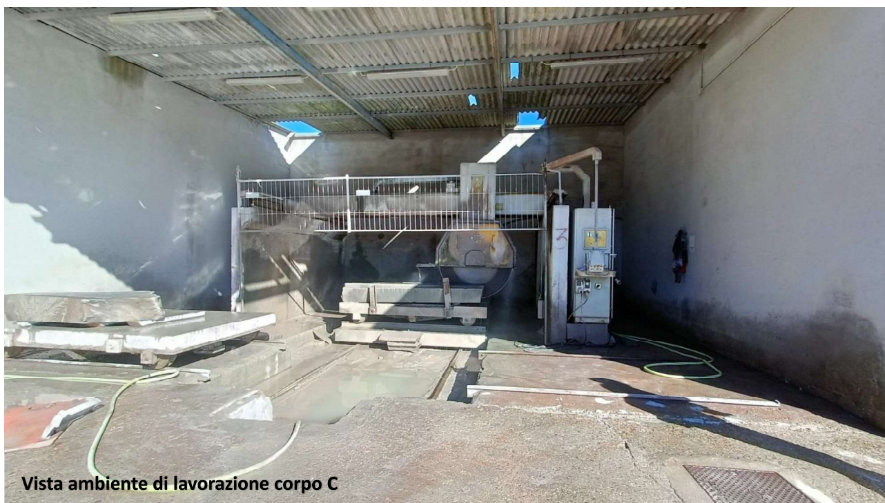
Vista generale tettoia corpo C
