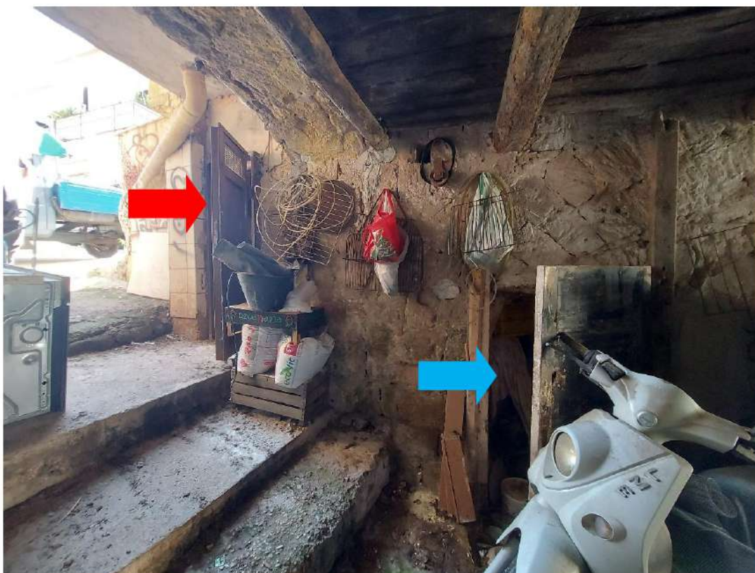
Porta accesso locale 1 ( rosso) locale 2 (celeste)
