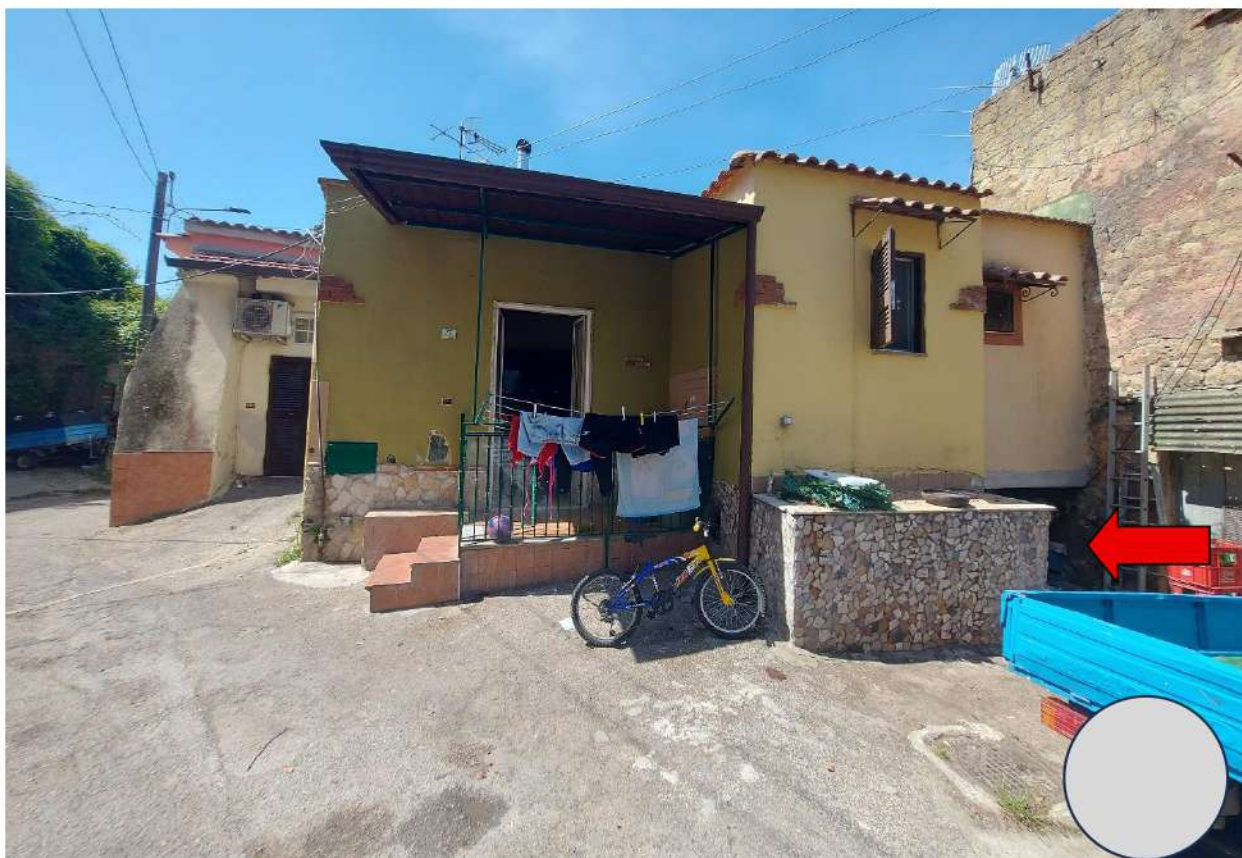
Corte p.lla 30 – indicazione accesso alla “grotta” del piano seminterrato dove è ubicato bene 2
