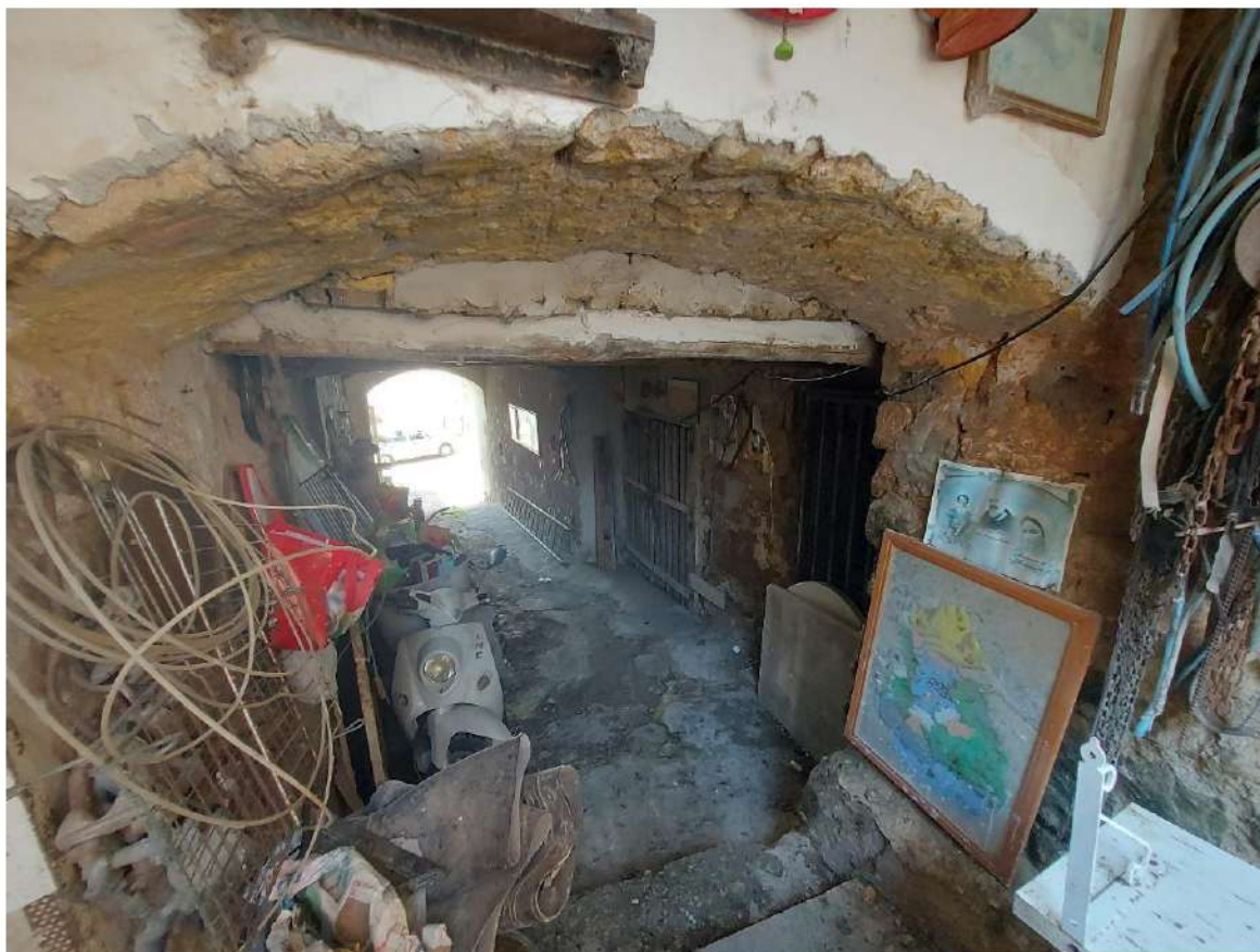
Accesso al piano seminterrato dove è ubicato bene 2
