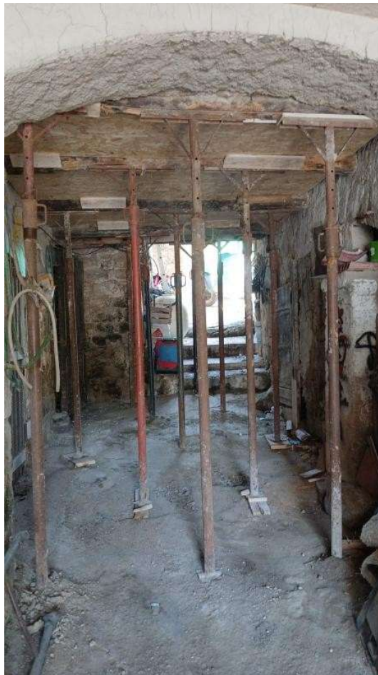
Messa in sicurezza solaio post intervento
