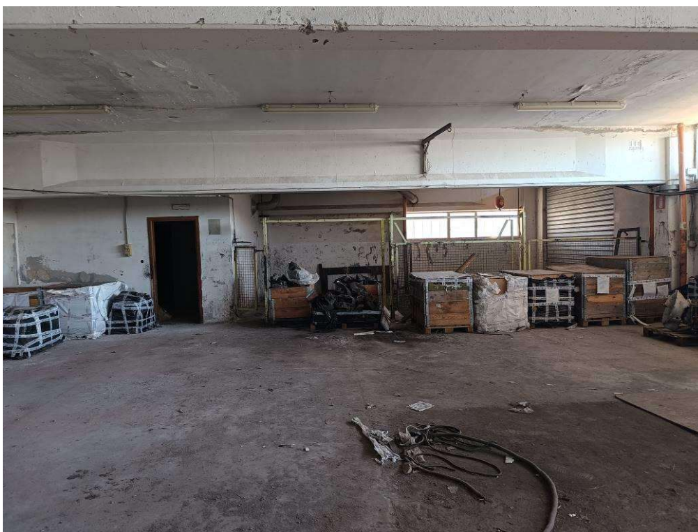
Foto 9 Sub. 6 P.T. Edif B2
