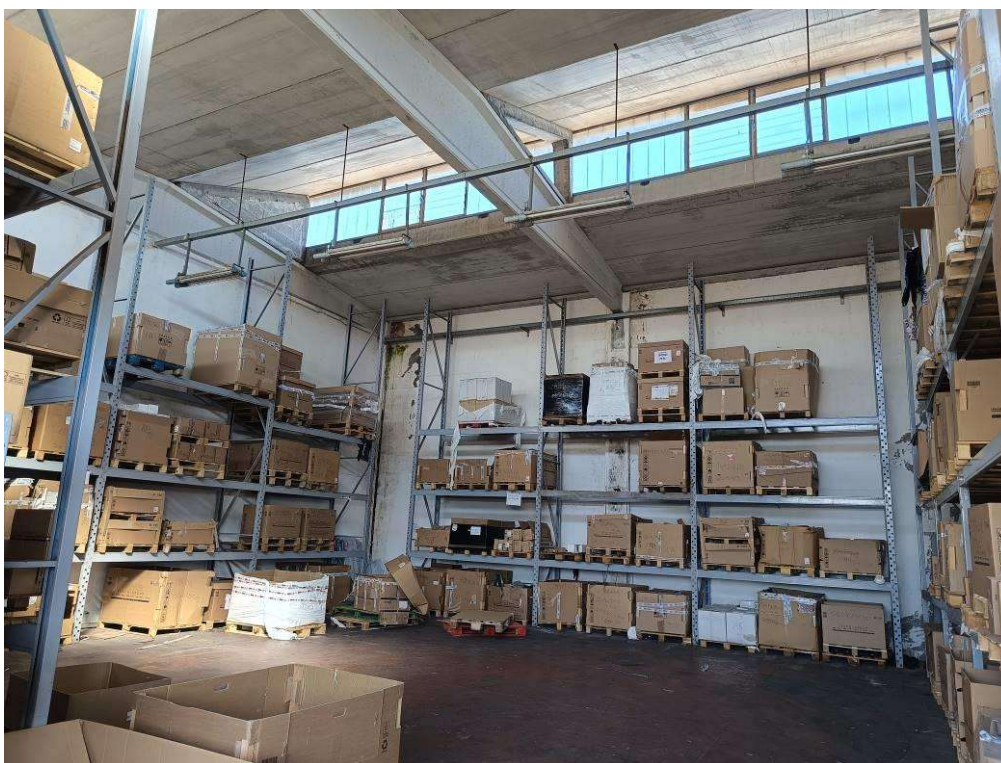
Foto 11 Sub. 6 P.T. Edif B2
