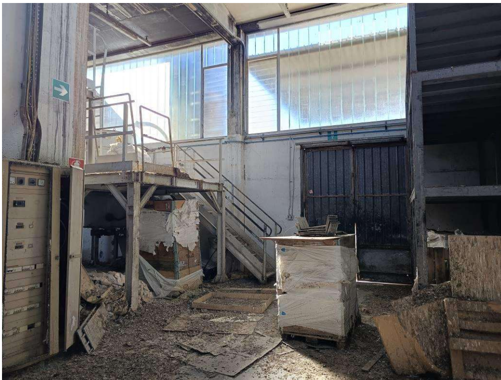
Foto 7 P.T. Sub. 6 Edif B2
