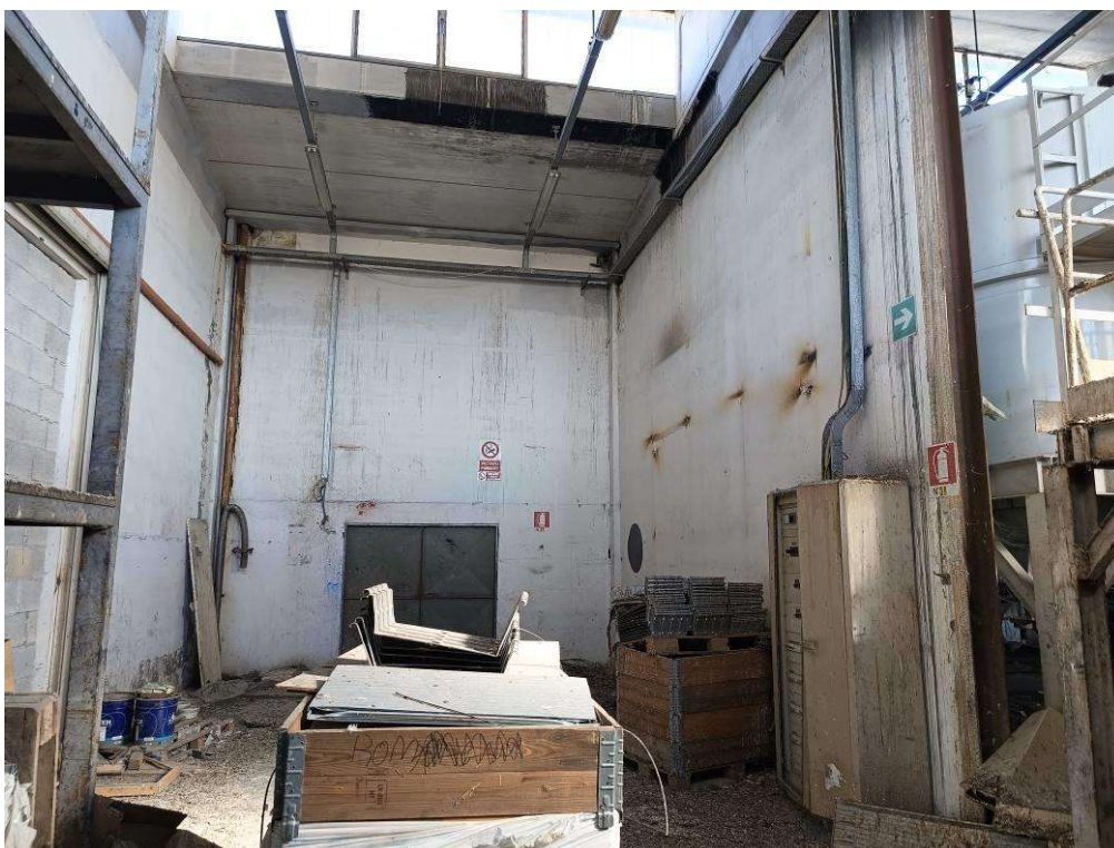
Foto 6 P.T. Sub. 6 Edif B2
