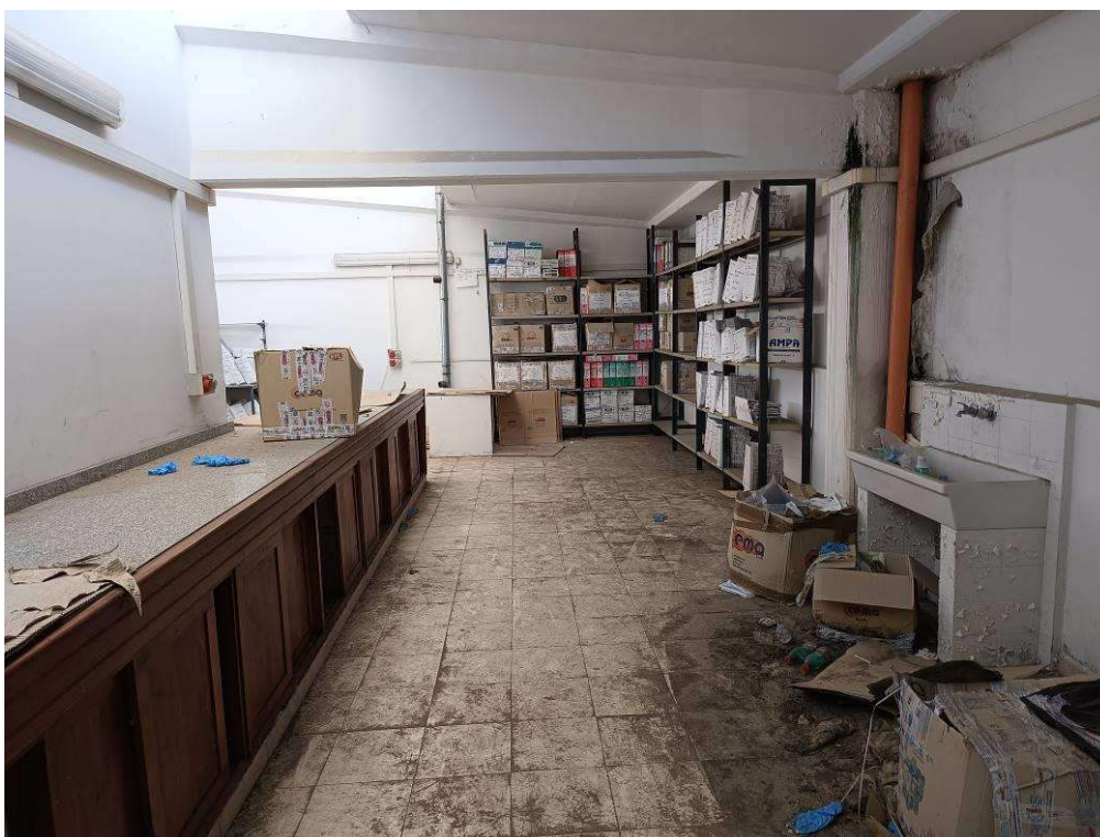
Foro 22 Sub. 6 P.1° Edif B2
