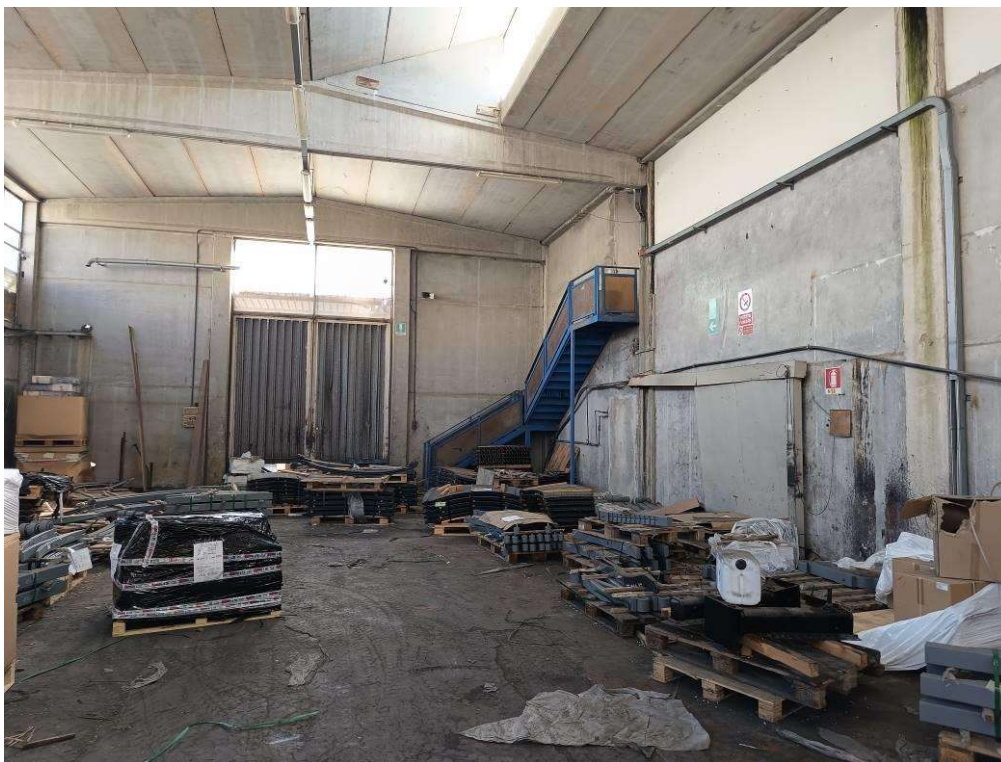
Foto 14 Sub. 6 P.T. Edif B2
