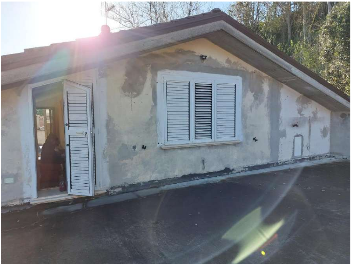
Vista esterna con porte accesso terrazzo
