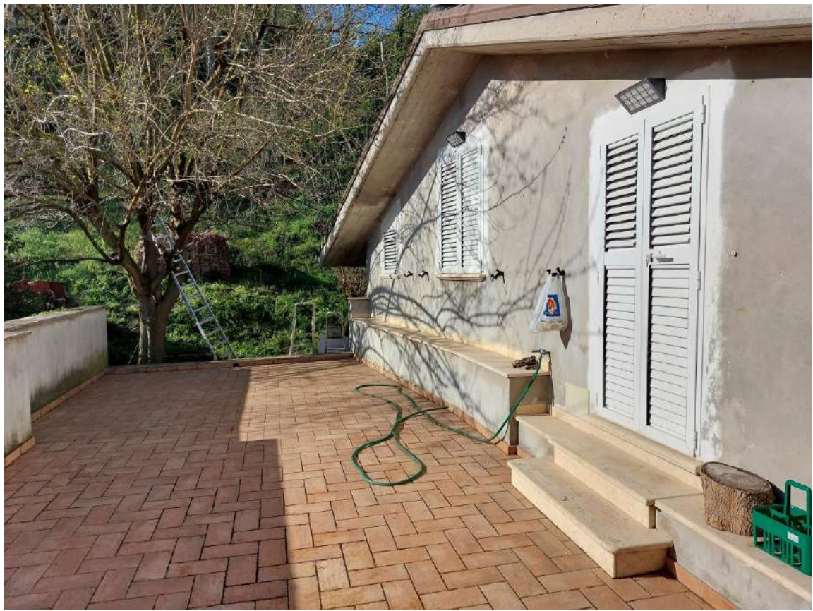
Vista esterna P1 appartamento (rif B)
