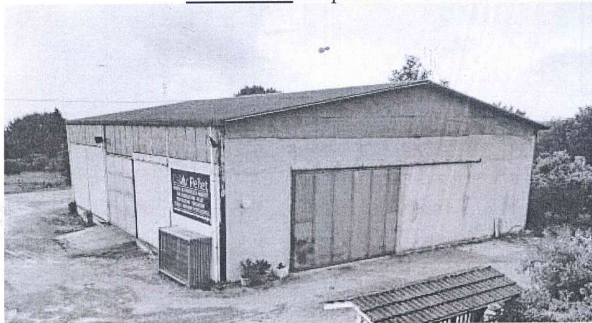
FOTO n. 4 Il capannone visto nel suo insieme
