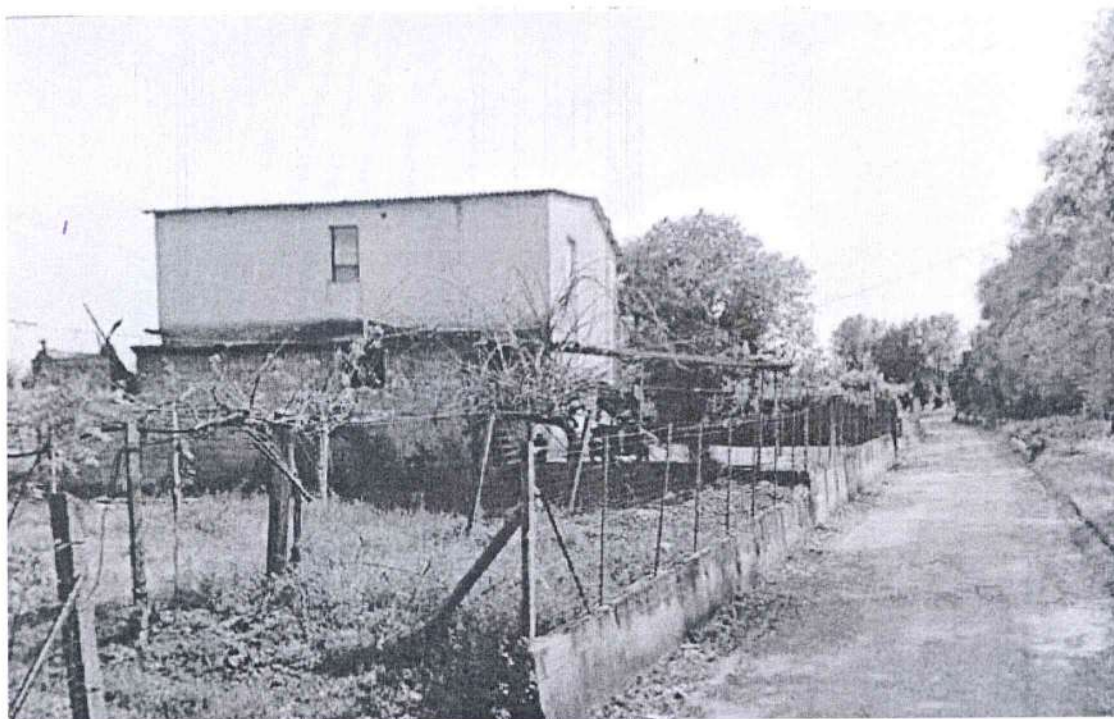
FOTO n. 4 – Le pertinenze esterne – tettoia, rampa di accesso
