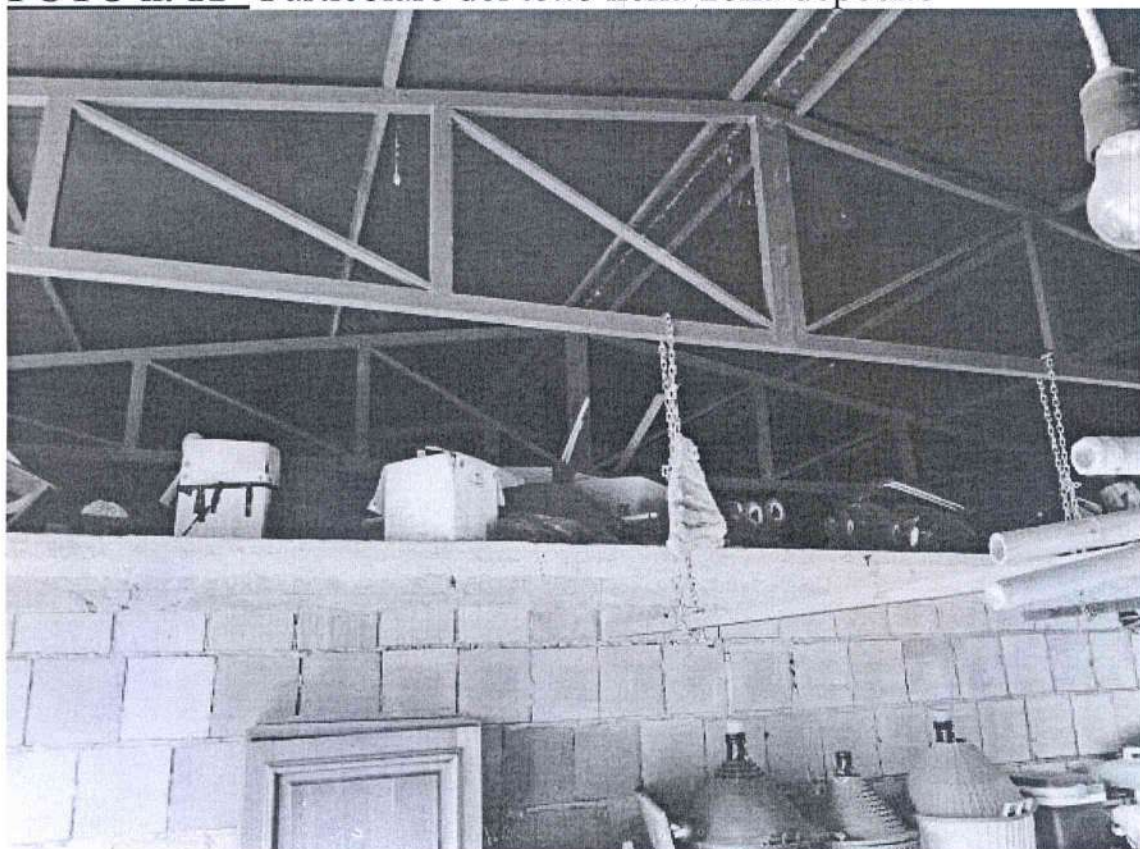
FOTO n. 11 Particolare del tetto nella zona deposito
