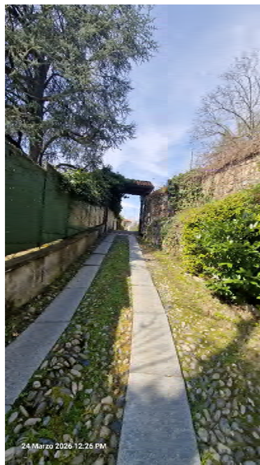
Ingresso carraio all'immobile
