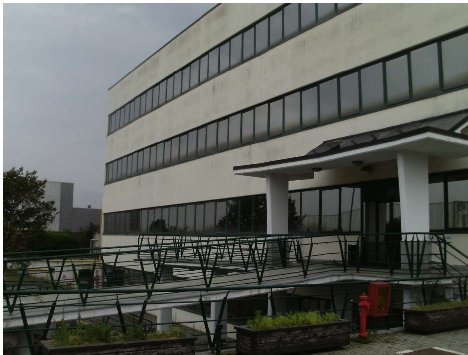
Figura 2 lato E ingresso
