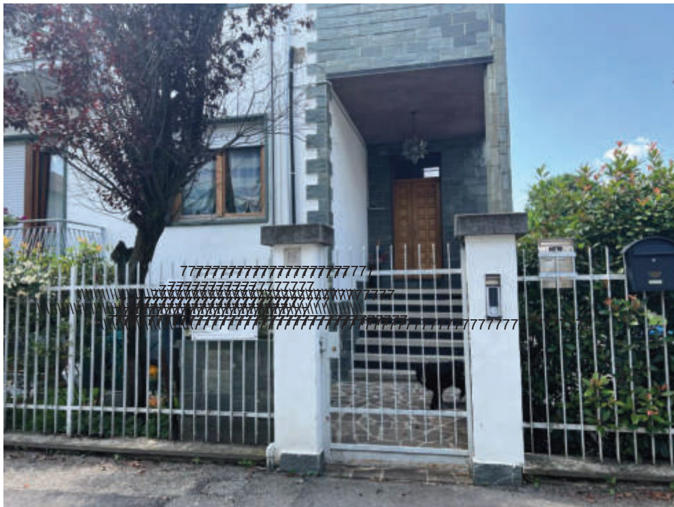
Fotografia n. 3 – Particolare del cancello di ingresso alla palazzina di Via Vincenzo Bellini n. 18 in Bollate
