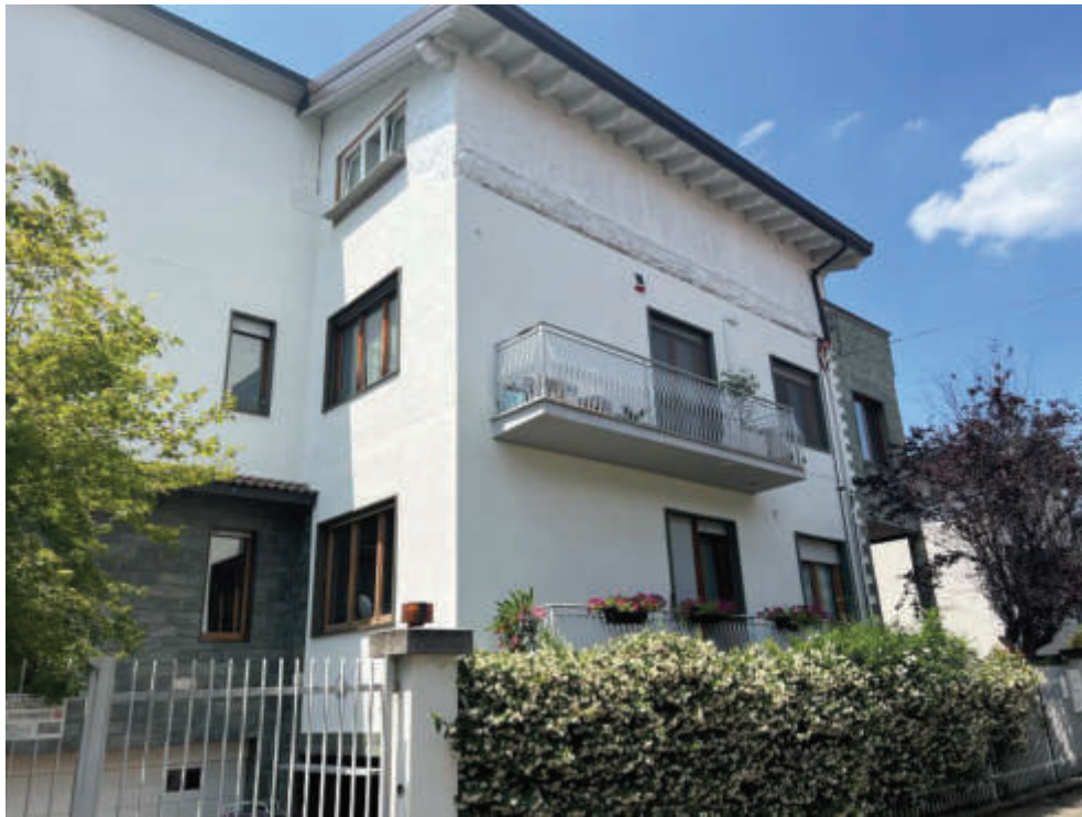
Fotografia n. 2 – Vista della palazzina di Via Vincenzo Bellini n. 18 in Bollate, con particolare del sottotetto s.p.p. con terrazzo (in fase di completamento della pratica di P.d.C. per recupero di sottotetto ai fini abitativi)
