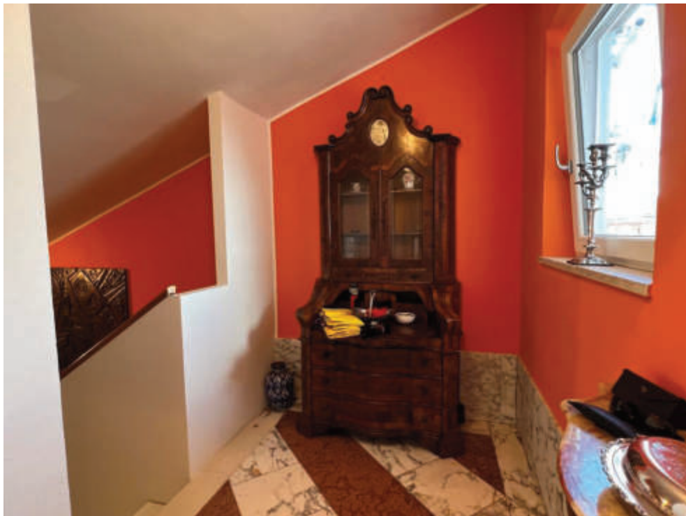
Fotografia n. 11 – Vista dell'ingresso all'appartamento oggetto della procedura, con particolari della parete, in parte h. 110 cm. c.ca e in parte a tutt'altezza, che funge da parapetto della rampa, e della porta-finestra trasformata in finestra
