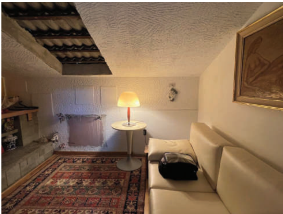
Fotografie n. 28/29 – Viste del locale camera 1, con apertura in falda per realizzazione di un futuro lucernario
