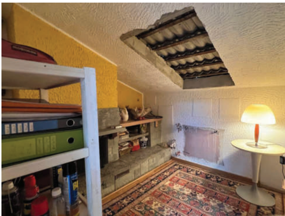
Fotografie n. 28/29 – Viste del locale camera 1, con apertura in falda per realizzazione di un futuro lucernario
