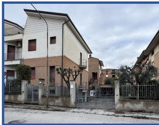
INGRESSO GARAGE VIA GUICCIARDINI, 17
