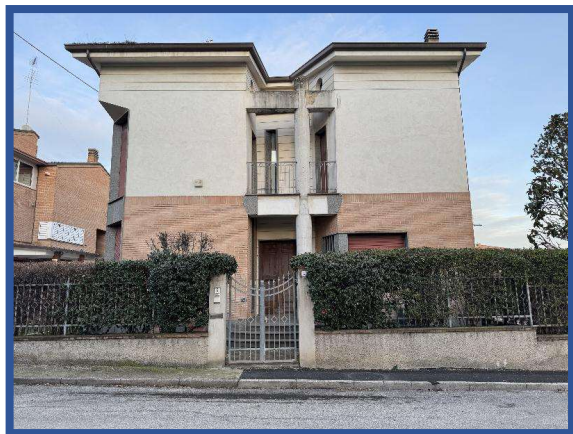
INGRESSO ABITAZIONE VIA GIACOSA, 25
