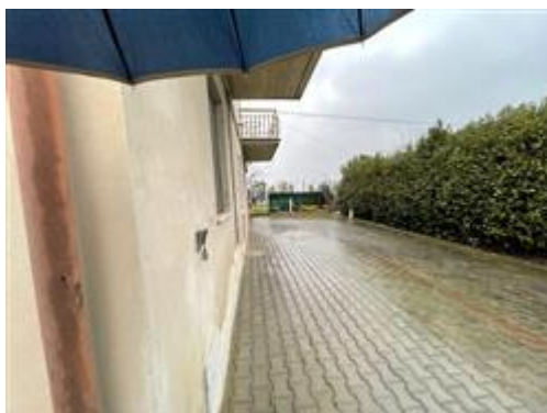
corte esterna condominiale
