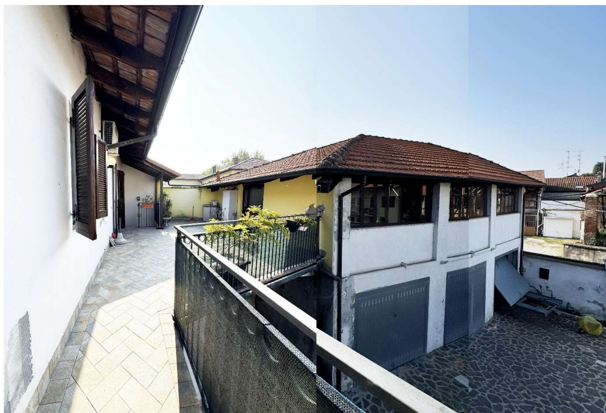
Foto nn. 9-10-11. Piano Primo. Ingresso abitazione
