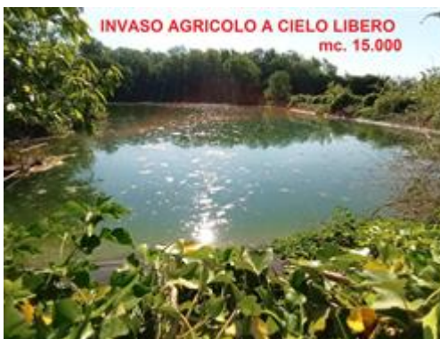
Invaso agricolo a cielo libero di capacità 15.000 mc. con evidenza stato di incuria
