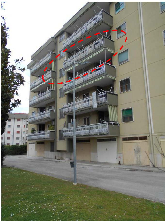
Foto 5- Prospetto sud su corte comune del fabbricato B Vista balcone sud abitazione (sub 81)
