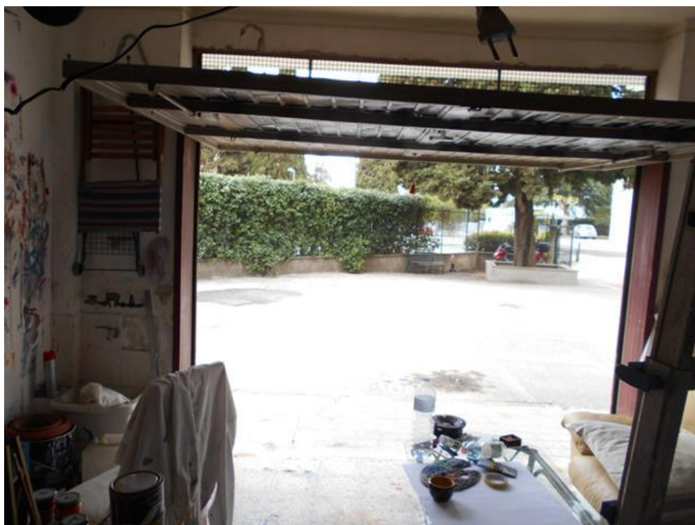
Foto 24- Locale garage al piano terra in NCEU al FL 2, P. LLA 1095, SUB 52
