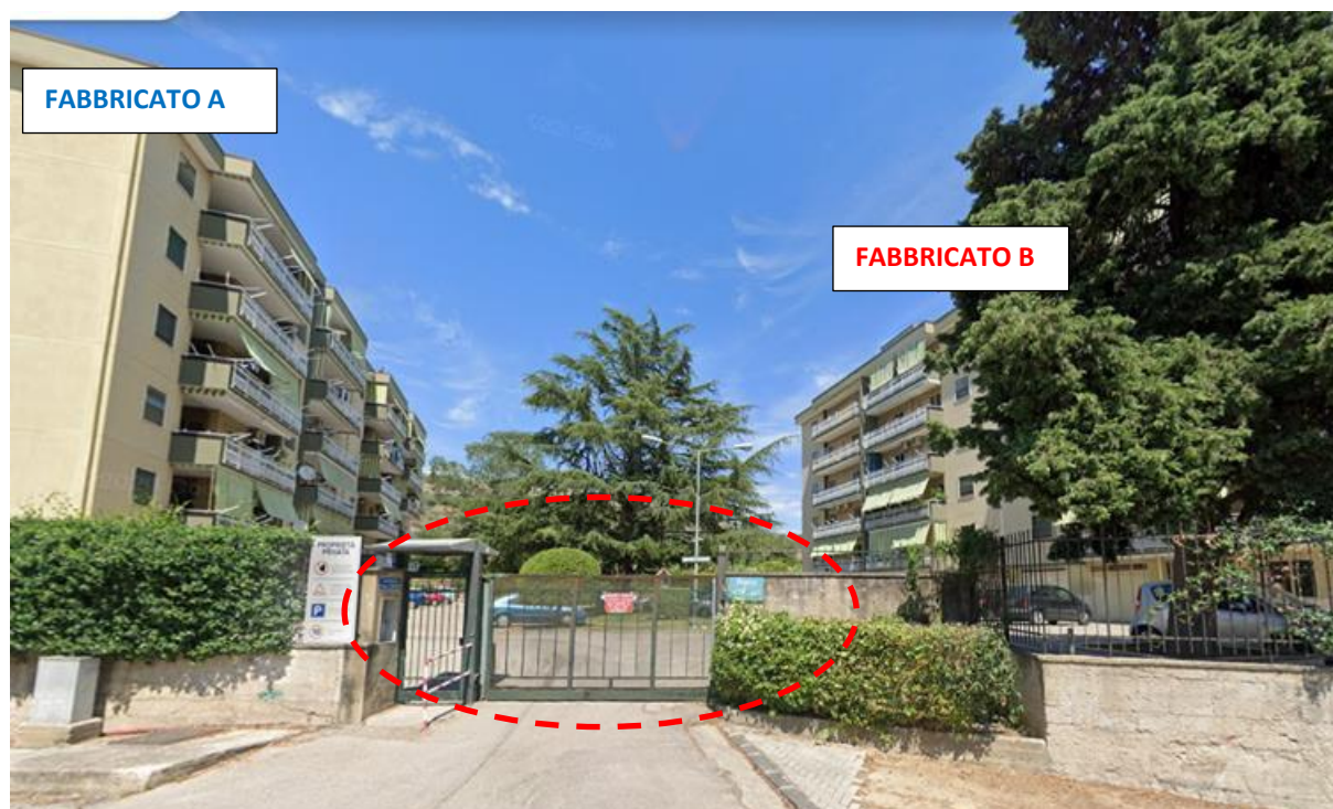
Foto 2-VISTA FABBRICATI DEL CONDOMINIO 'PARCO GRAZIA', DETTAGLIO ACCESSO ALLA CORTE COMUNE (fonte street wiew)
