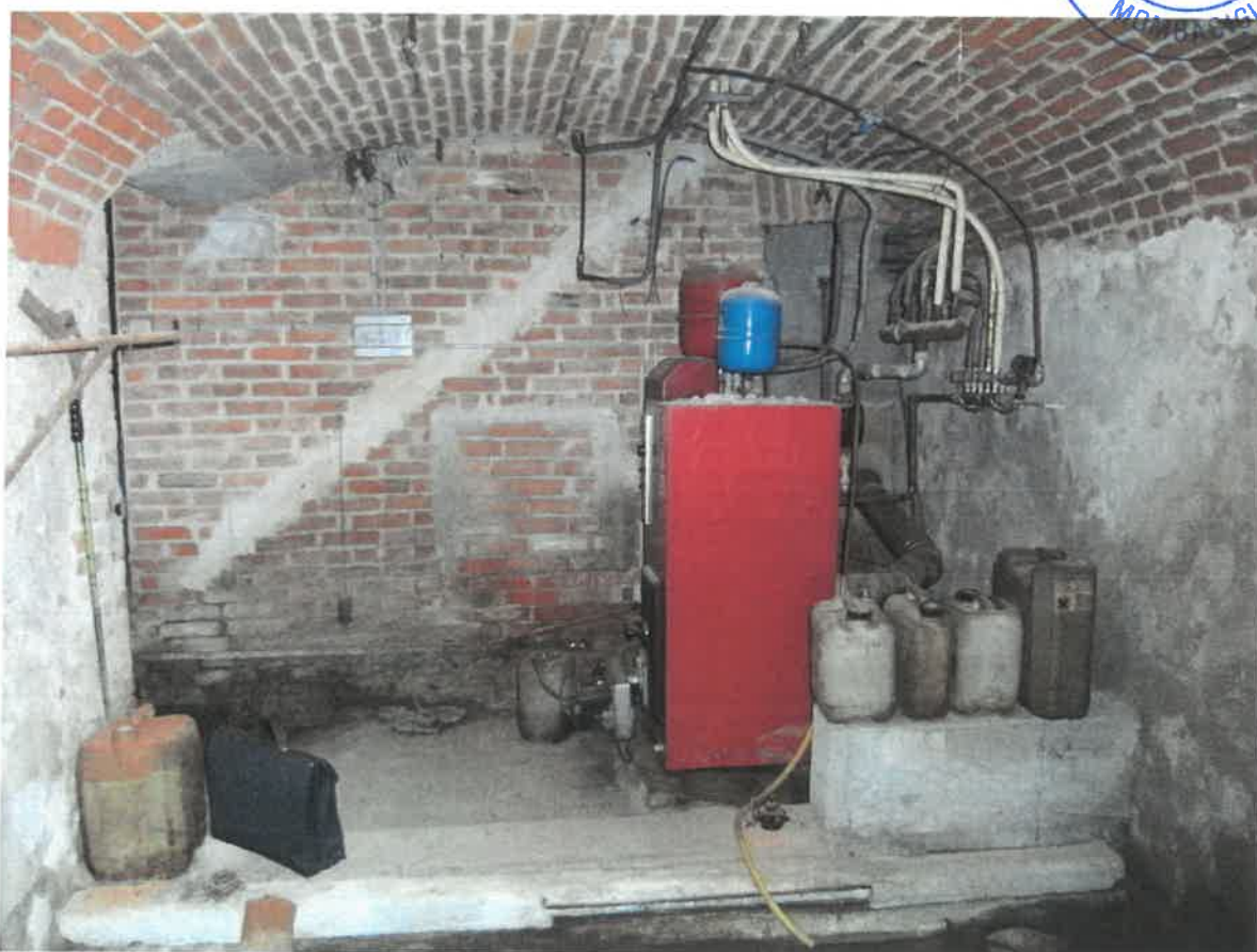
06. Cantina con C.T. al piano primo sotterraneo -f. 11 n. 148 sub. 7.JPG
