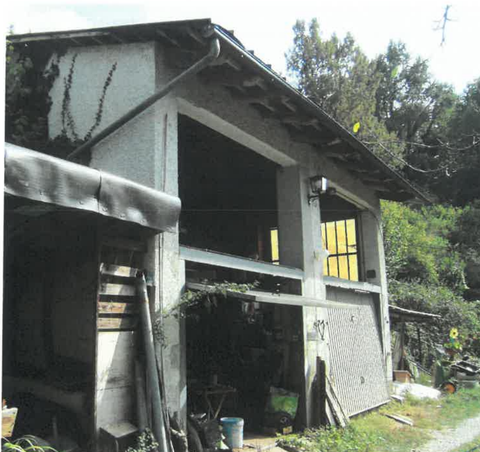
15. Locale di deposito, prospettiva da nord-ovest - f. 11 n. 151.JPG
