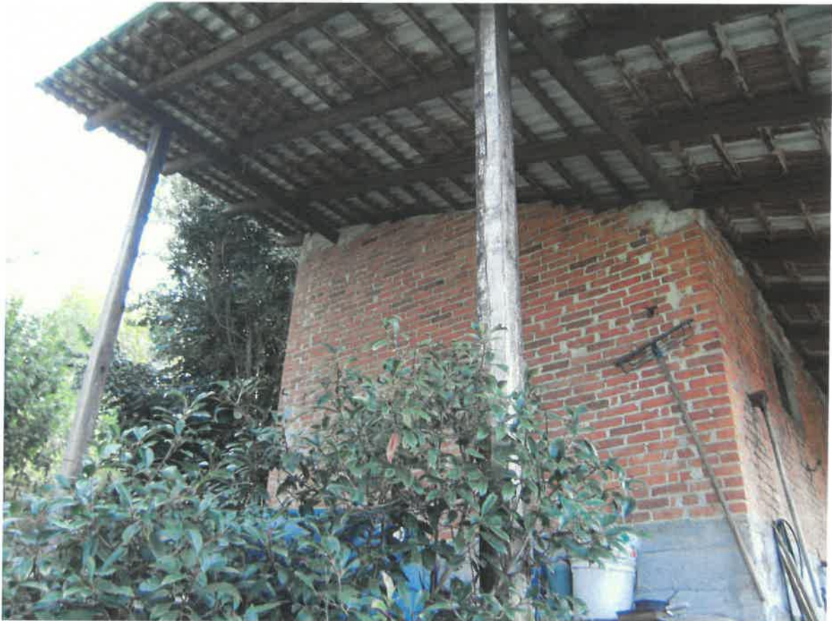
21. Locale di deposito, prospettiva da nord, piano terreno - f. 5 n. 490.JPG
