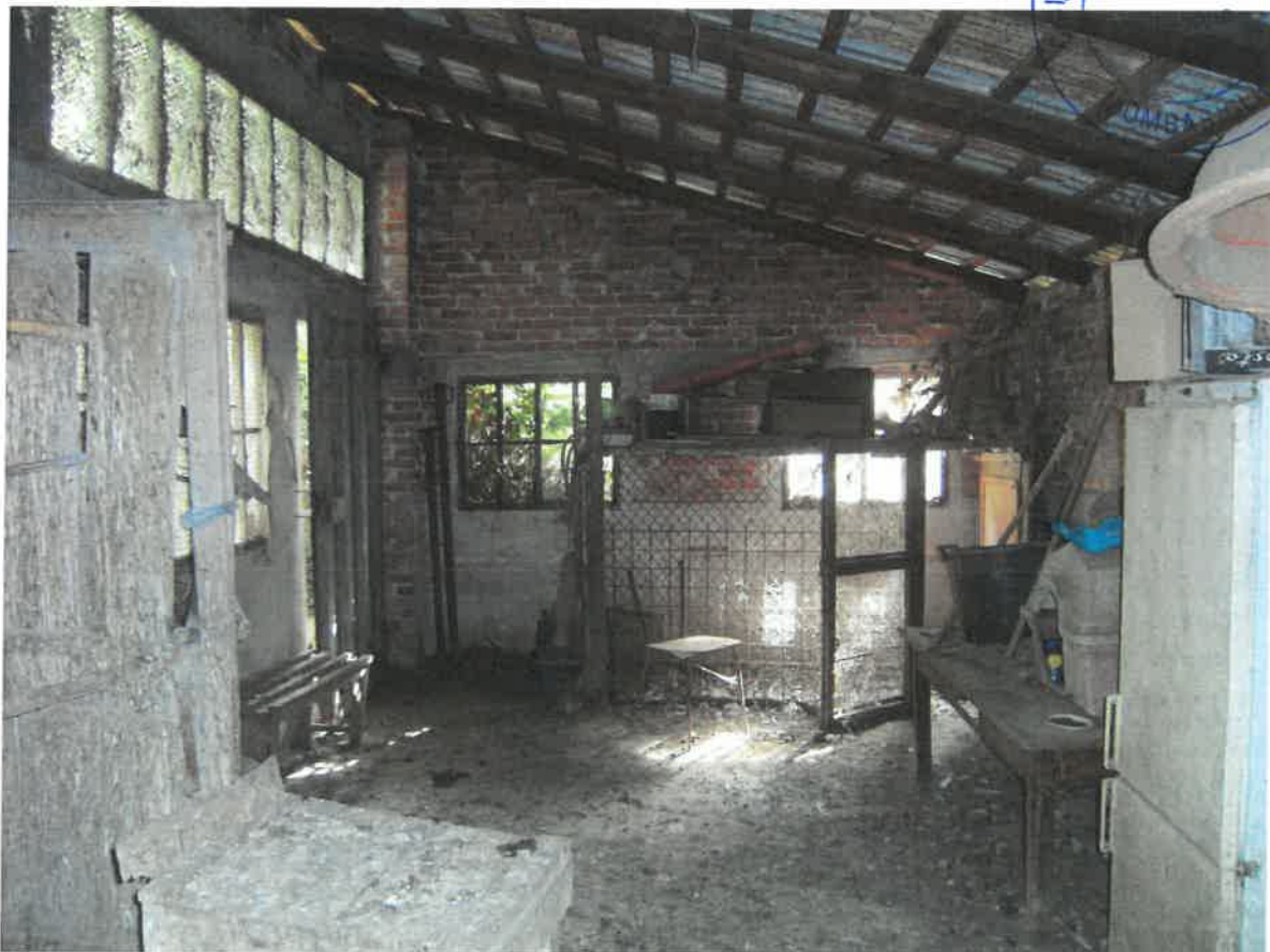
22. Locale di deposito piano terreno - f. 5 n. 490.JPG
