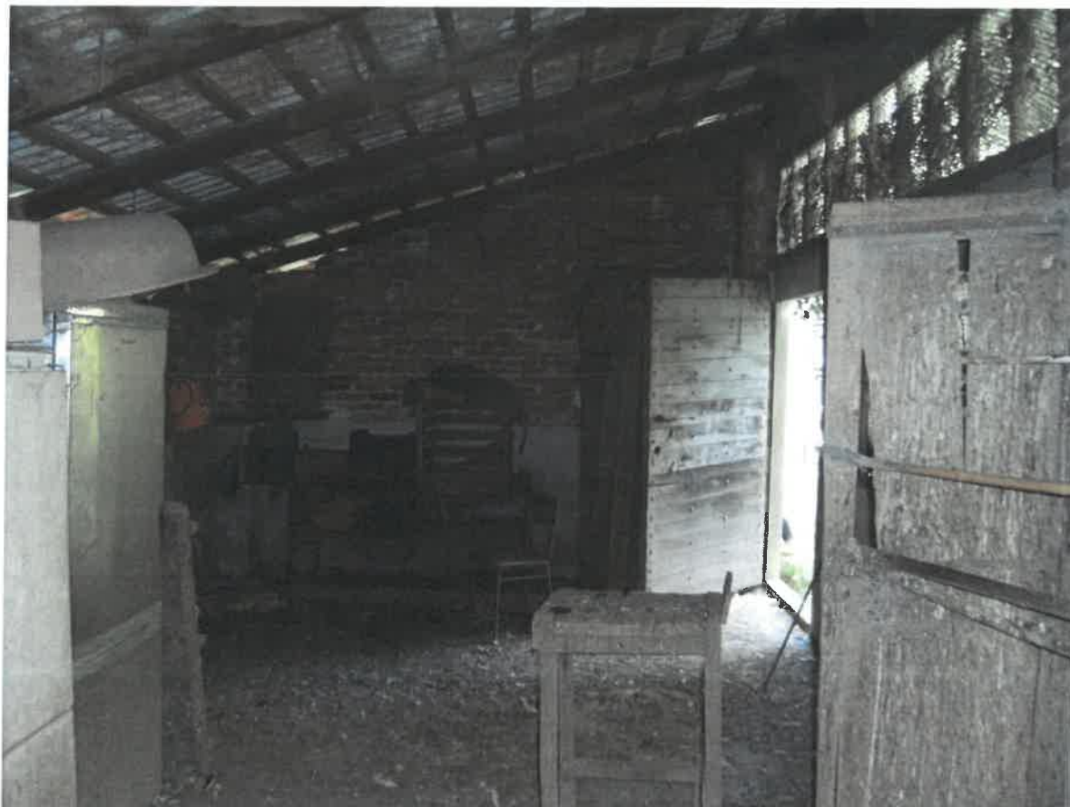
23. Locale di deposito piano terreno - f. 5 n. 490.JPG
