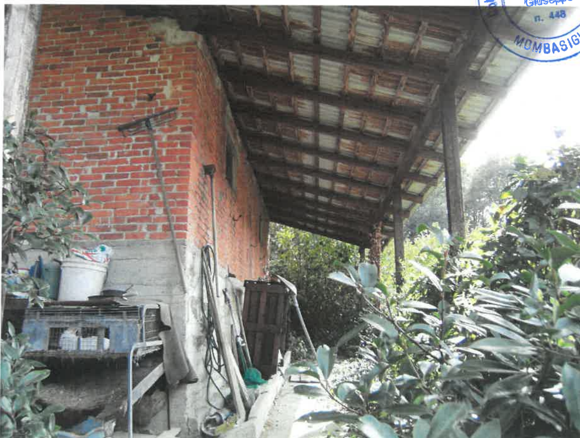
20. Locale di deposito, prospettiva da ovest, piano terreno - f. 5 n. 490.JPG
