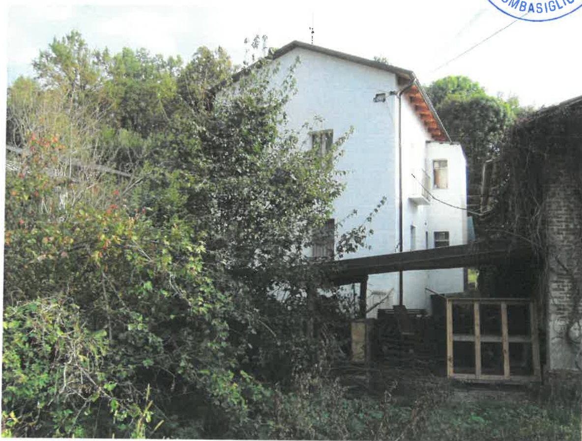
04. Abitazione, prospettiva da nord-ovest, f. 11 n. 148 sub. 7.JPG
