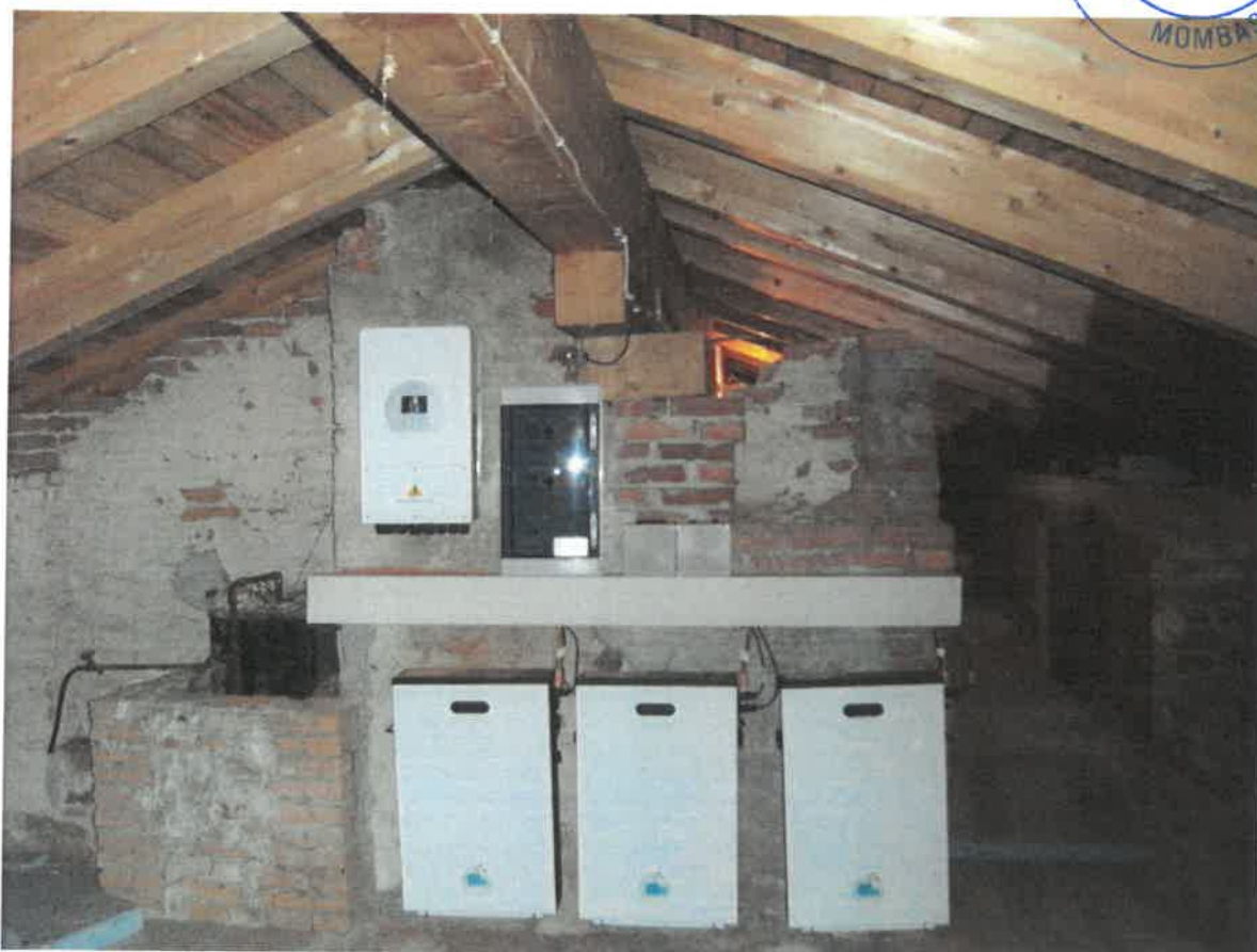
14. Sottotetto al piano secondo - f. 11 n. 148 sub. 7.JPG
