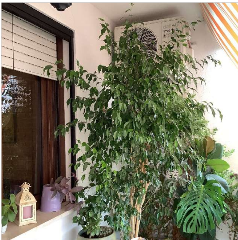
FOTO 16_ balcone_1 su lato concavo del complesso edilizio, con affaccio su Via Bruxelles
