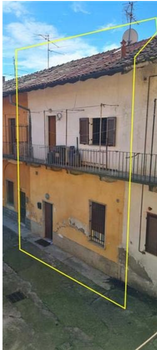
Fronte nord dalla corte comune
