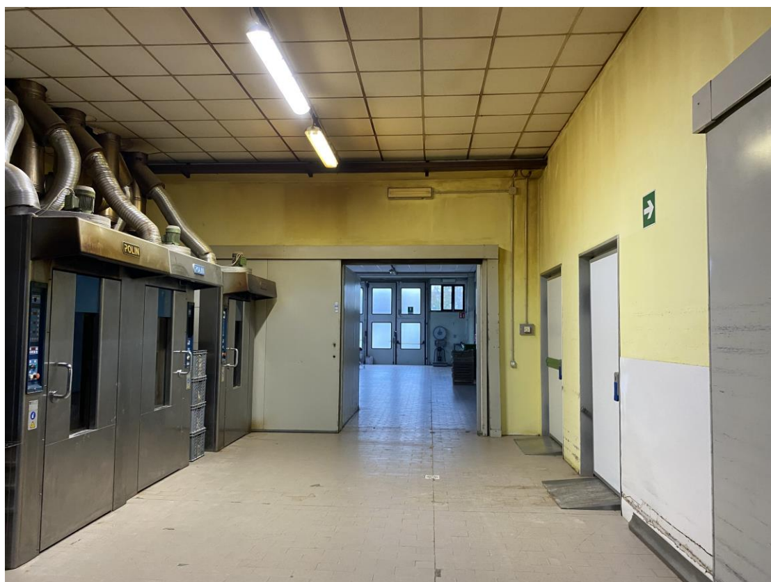
AREA FORNI VERSO AREA SPEDIZIONE
