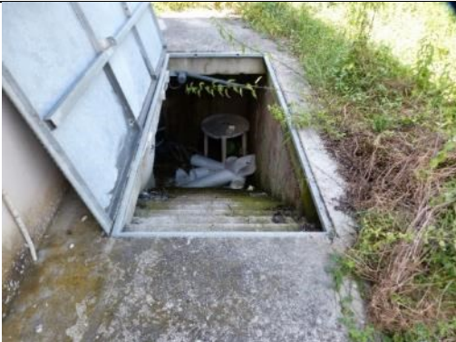
Botola con scale che conducono nell'interrato
