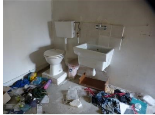
Particolare bagno / lavanderia
