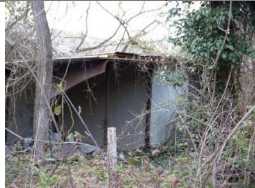
Manufatti in lamiera utilizzati a depositi
