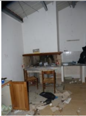
Interno con vista sul camino
