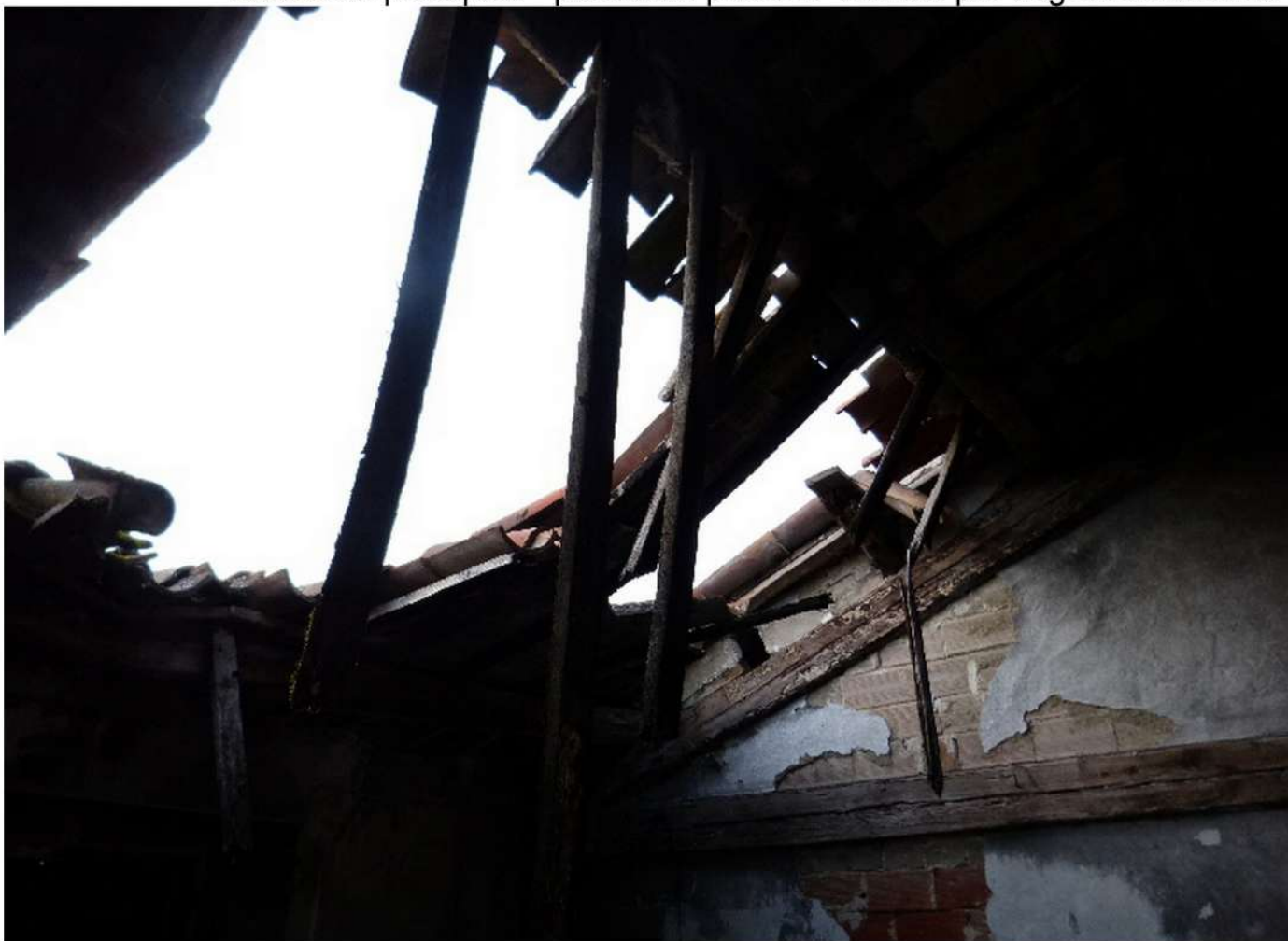
fabbricato principale - particolari porzioni crollate per degrado/instabilità
