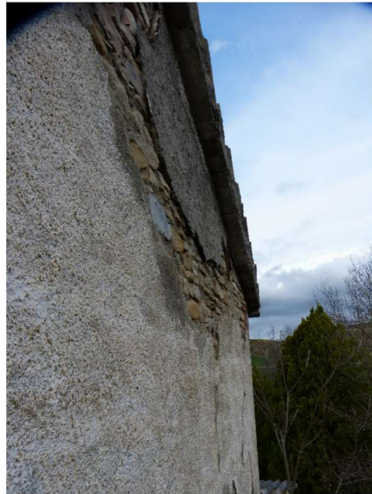
fabbricato principale - particolari porzioni crollate per degrado/instabilità
