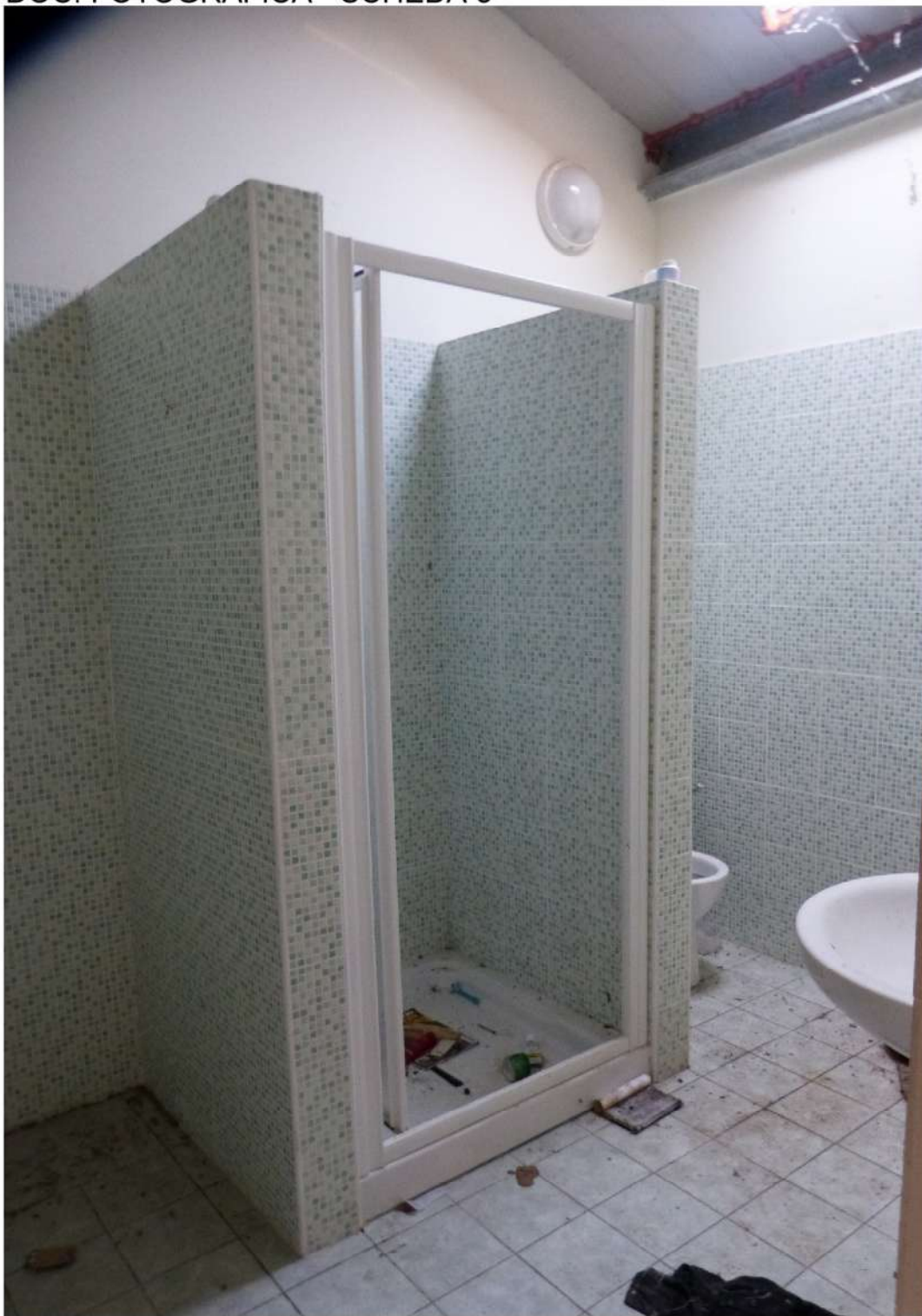
locale bagno wc presente nel titolo edilizio SCIA 7080/2011, N.B.agibilità NON ottenuta
