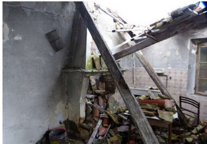
fabbricato principale - particolari porzioni crollate per degrado/instabilità
