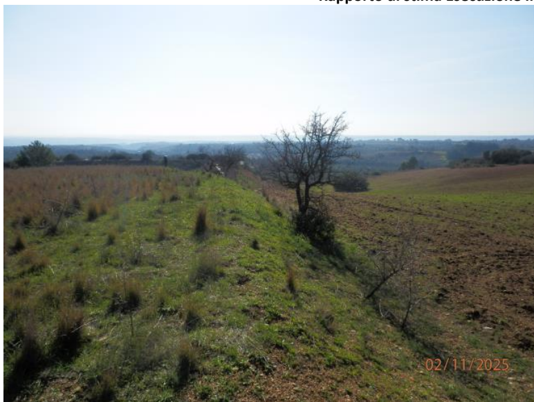
scarpata al confine nordest
