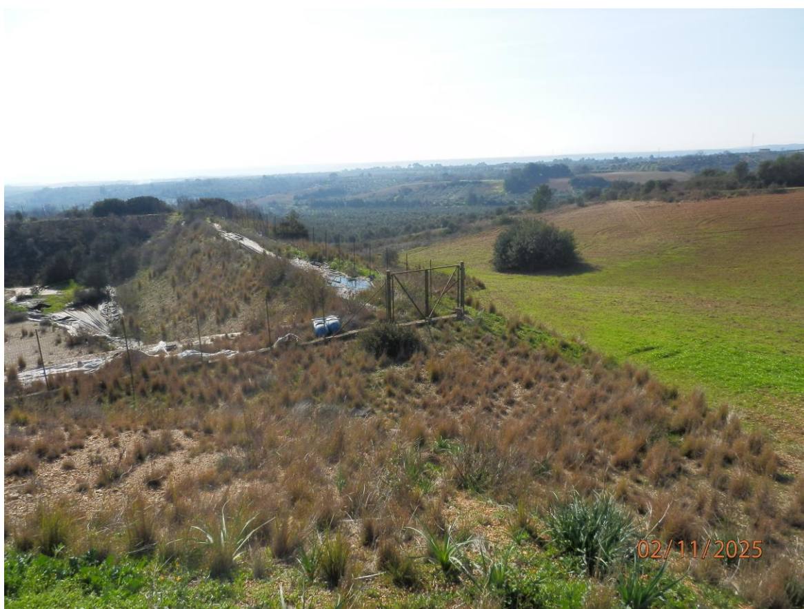
Foto 6 - vasca di irrigazione dismessa (p.lla 130 non eseguita) al confine est del Lotto (Corpi C-D)
