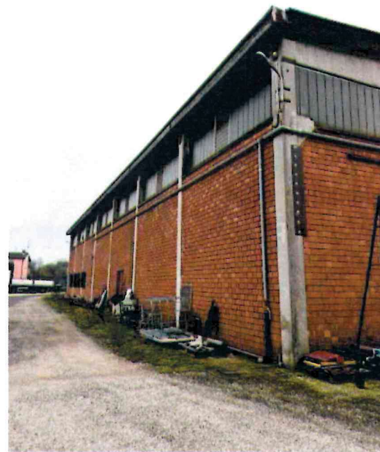
FRONTE OVEST- CAPANNONE N.1
