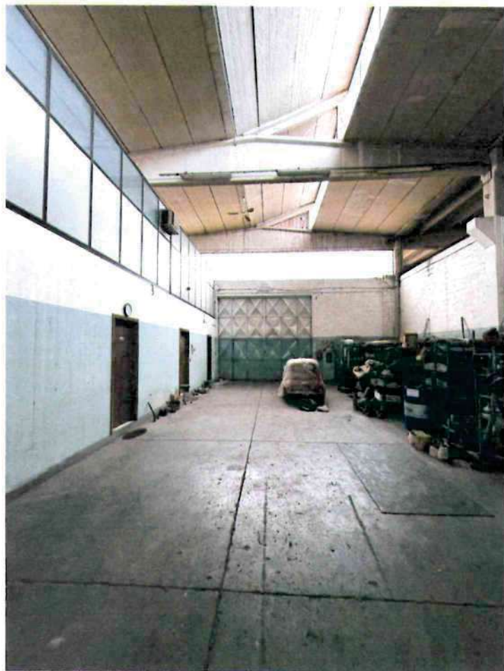
INTERNO CAPANNONE N.1- VEDUTA PORTONE SUD
