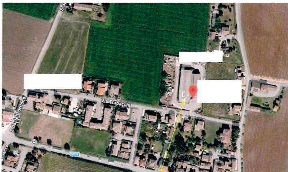
Veduta aerea dell'immobile industriale
