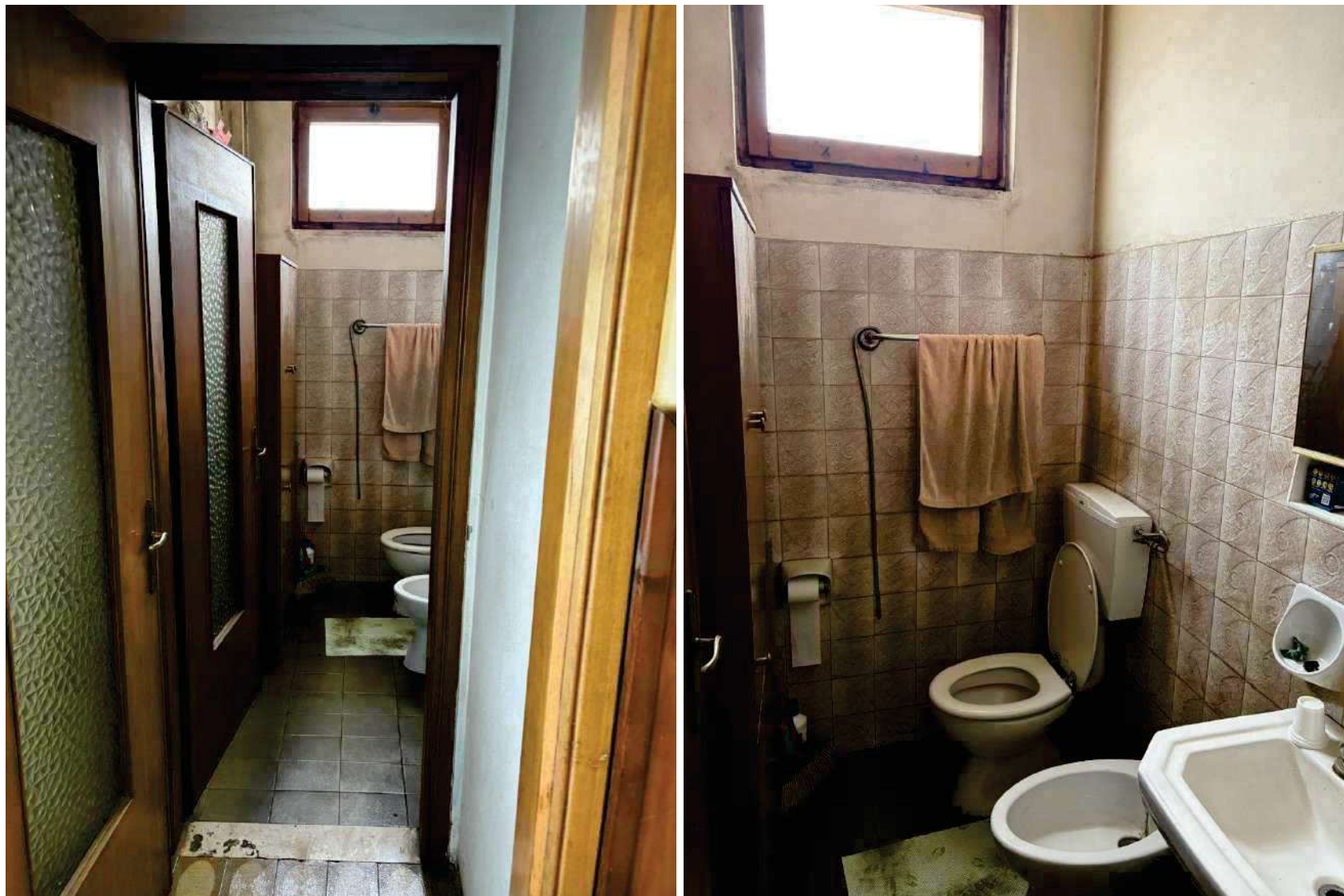
INTERNO CAPANNONE N.1 – BAGNO A SERVIZIO DEL PRIMO UFFICIO
