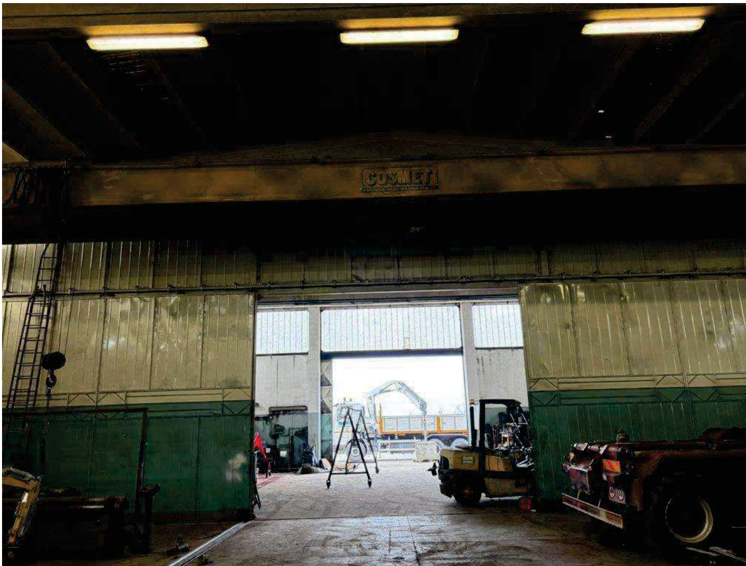
INTERNO CAPANNONE N.2- REPARTO LAVORAZIONE -PARETE DI COMPARTIMENTAZIONE IN FERRO TRA I DUE LOCALI E CARROPONTE DA 5T
