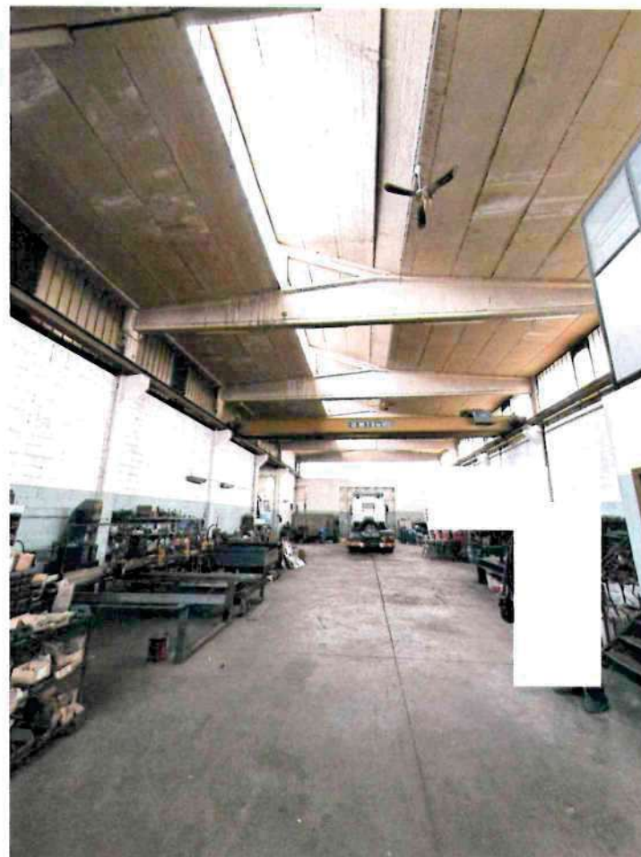
INTERNO CAPANNONE N.1- VEDUTA PORTONE NORD CON CARROPONTE DA 5T
