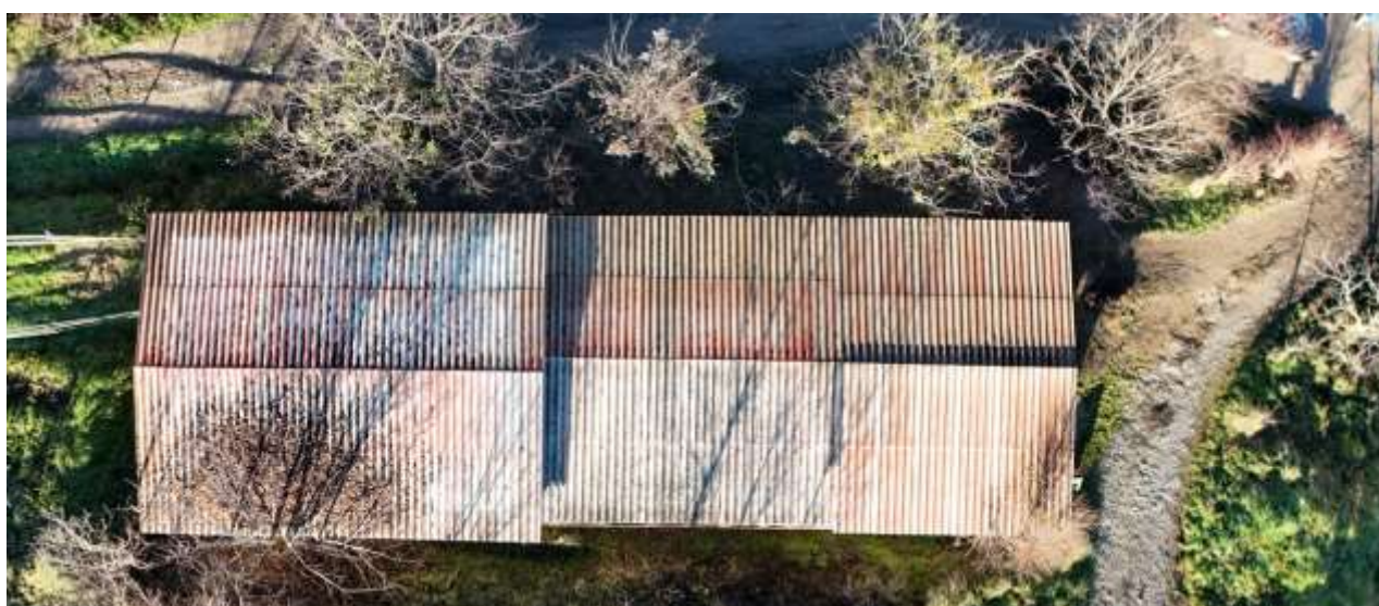
Viste costruzione B
