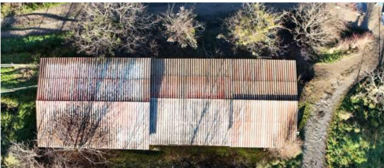
Viste costruzione B
