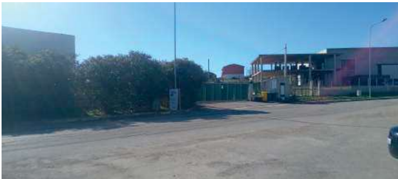
Vista da strada ingresso piazzale (sub4)
