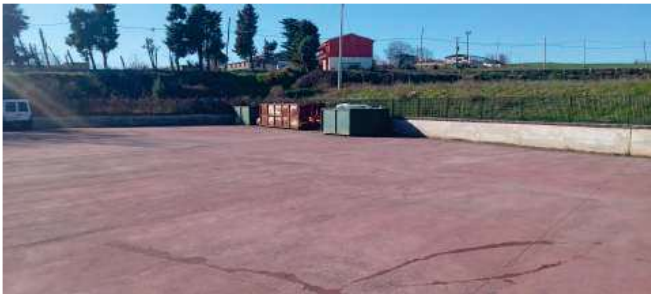
Piazzale lato Sud-Ovest (sub4)
