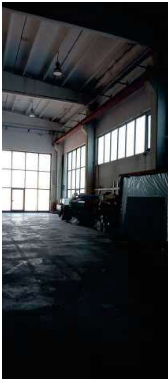
Capannone lato Nord-Ovest
