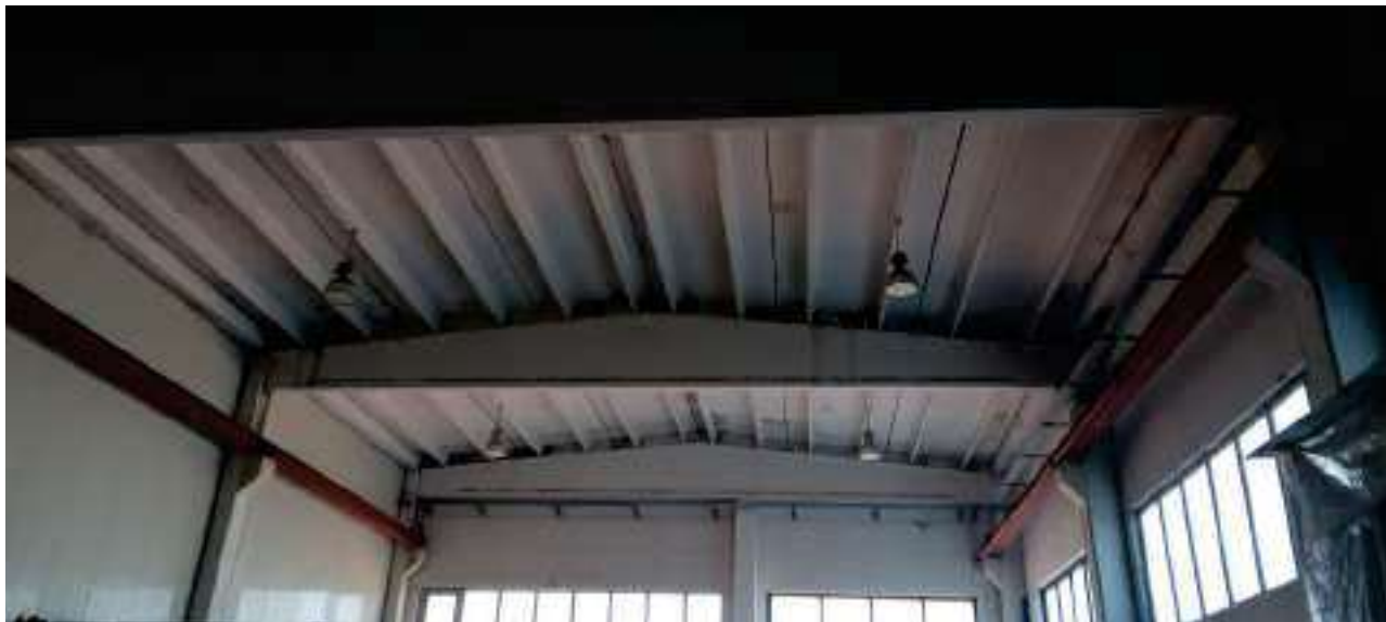
Capannone lato Nord-Ovest
