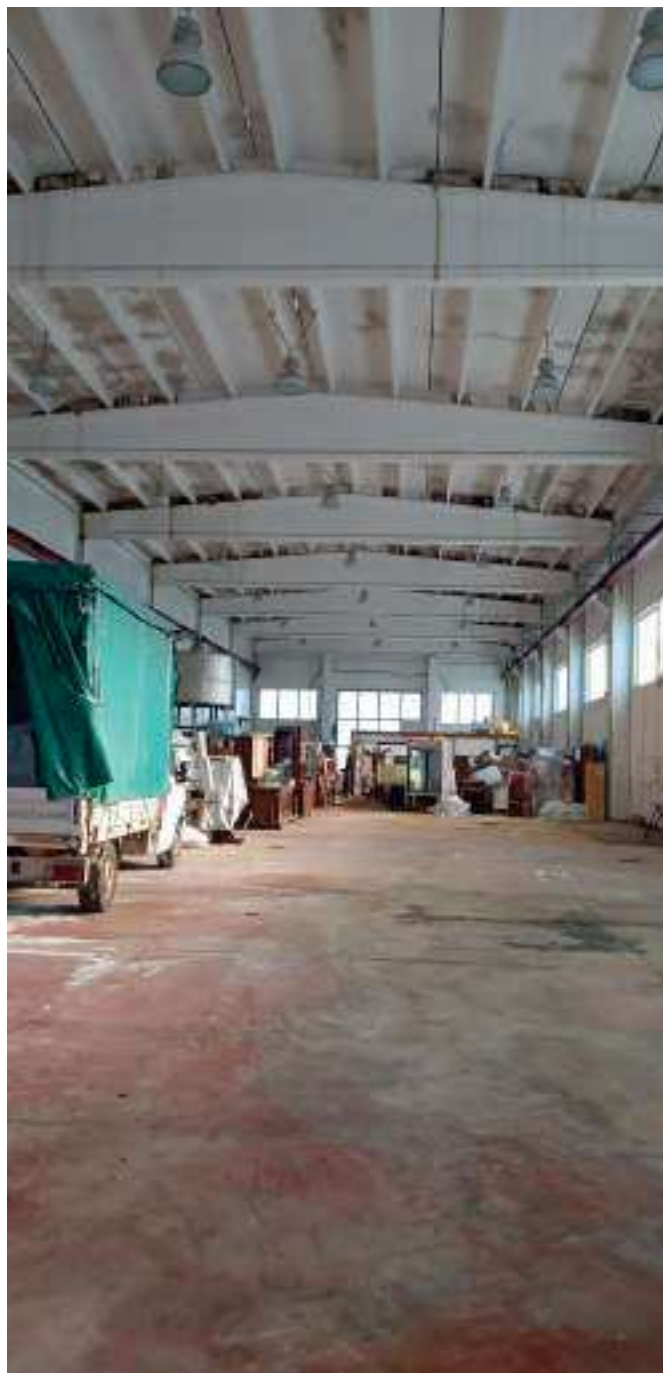
Capannone lato Sud-Est
