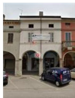
il negozio visto dalla strada
