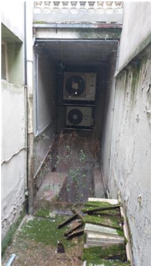
la scala che porta alla cantina
