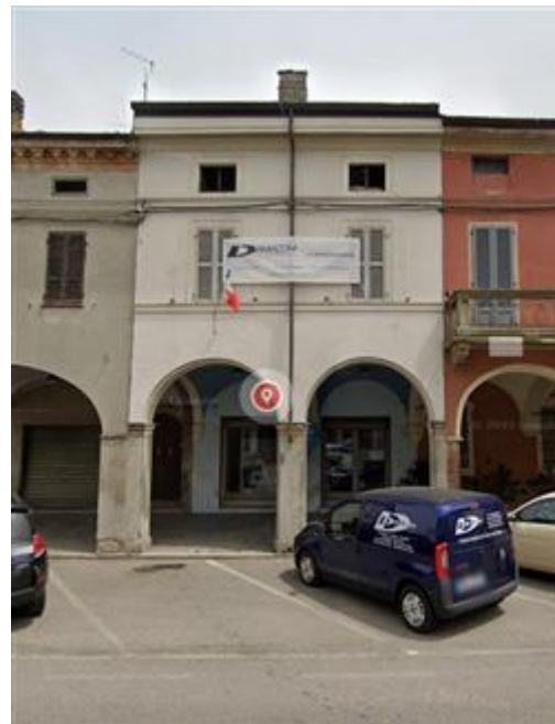
il prospetto su via cavour
