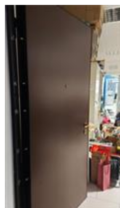
La porta blindata sul vano scala comune
