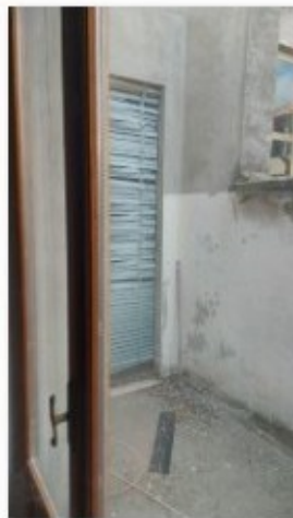
abitazione balcone su cavedio.jpg
