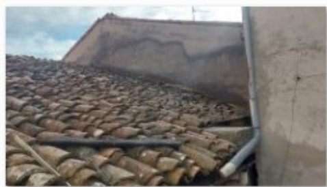
abitazione coperture depositi P1.jpg
