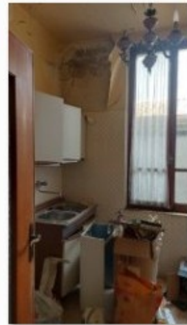
abitazione cucina 1.jpg
