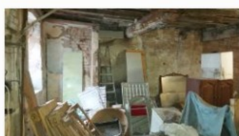
depositi bagni demoliti.jpg
