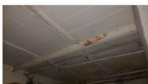
depositi solaio 1.jpg
