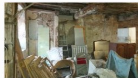
depositi bagni demoliti.jpg
