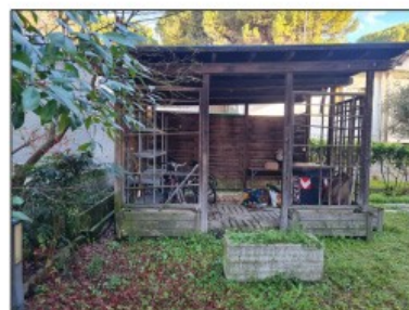
FOTO 29 - SISTEMAZIONE SU AUTORIMESSA NON CONFORME
