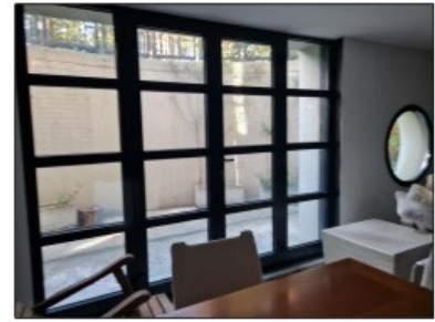
FOTO 63 - DETTAGLIO INFISSO CANTINA INTERRATA
