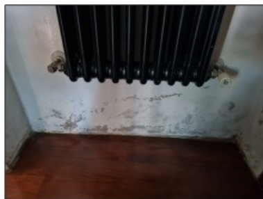
FOTO 108 - INFILTRAZIONE MURATURE
