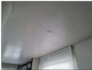
FOTO 113 - INFILTRAZIONE SOFFITTO
