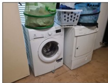
FOTO 54 - LAVANDERIA A P. INTERRATO
